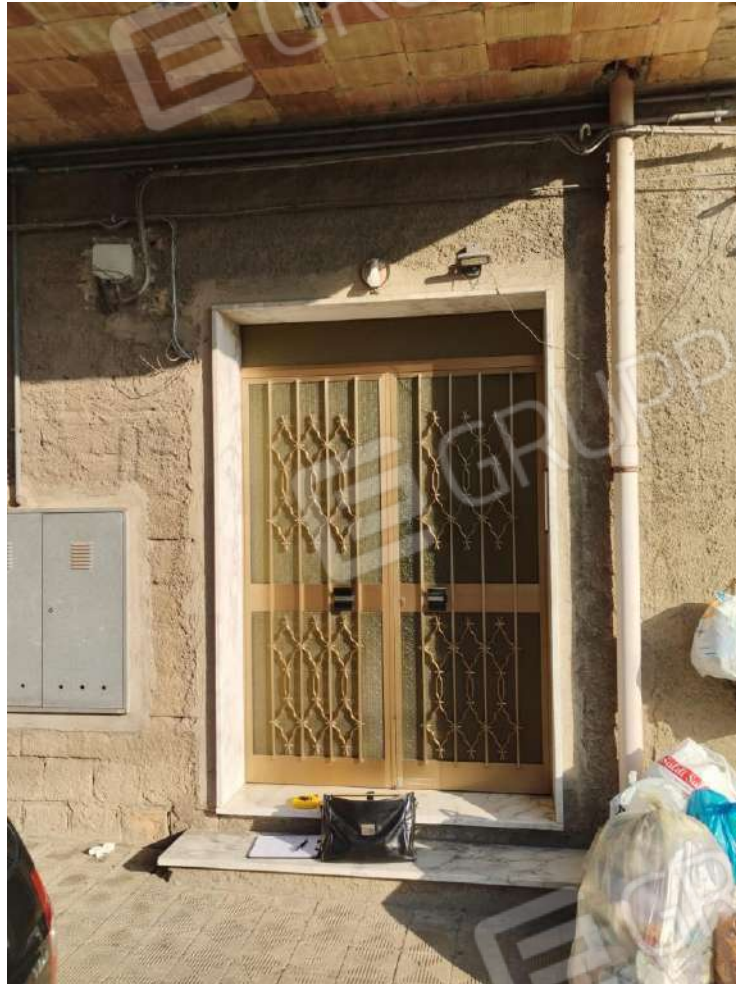
Foto 1: Ingresso allo stabile
