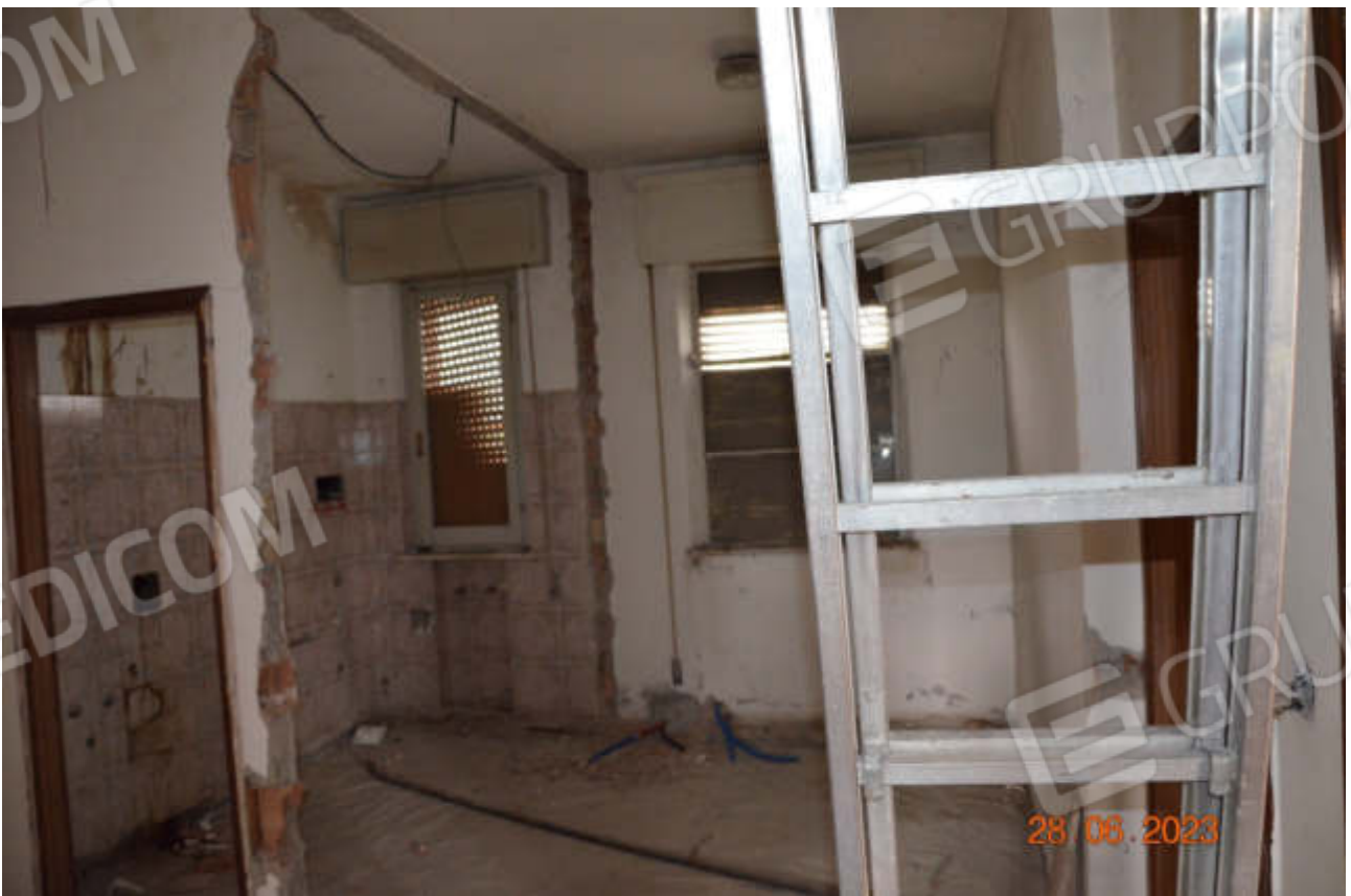
Bagno e disimpegno in costruzione.
