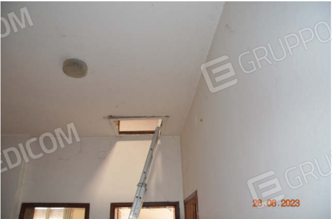
Accesso al sottotetto.
