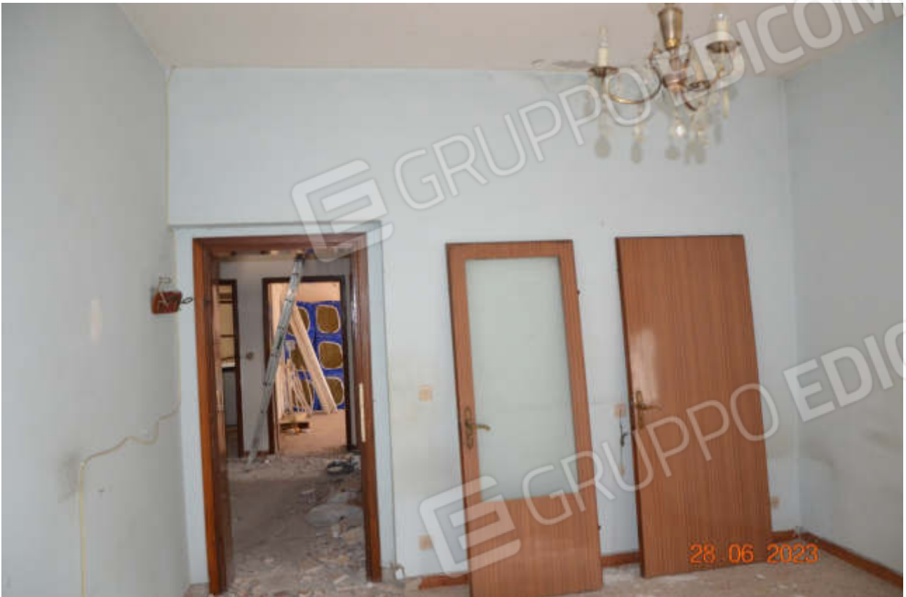
Camera sul lato sud/est.
