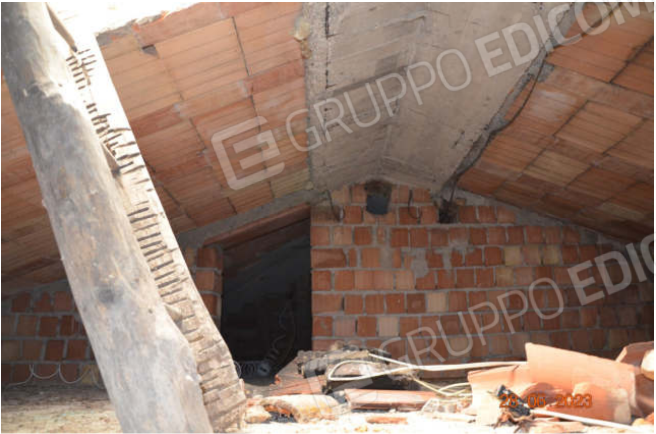
Il sottotetto allo stato grezzo è accessibile solo per manutenzioni.
