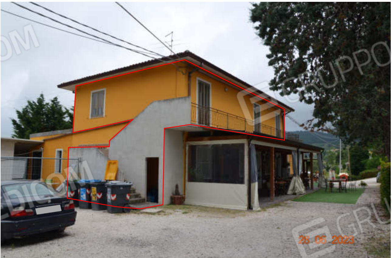
Appartamento al piano primo accessibile dalla scala esterna. Nel sottoscala è stato creato un ripostiglio senza titolo che andrà regolarizzato con la pratica in sanatoria.
