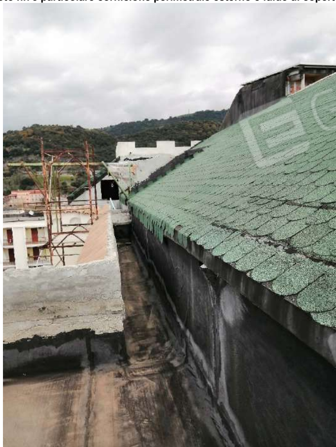
Foto n.75 particolare cornicione perimetrale esterno e falde di copertura
