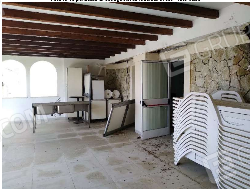
Foto n. 16 porticato di collegamento facciata ovest – lato mare -
