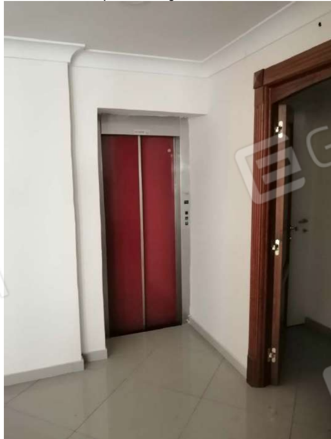
Foto n. 38 particolare ingresso vano ascensore-
