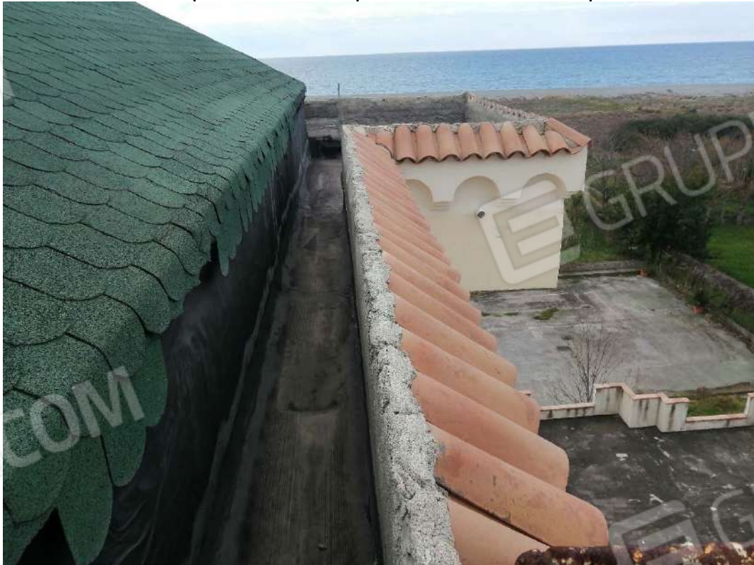
Foto n.73 particolare cornicione perimetrale esterno e falde di copertura
