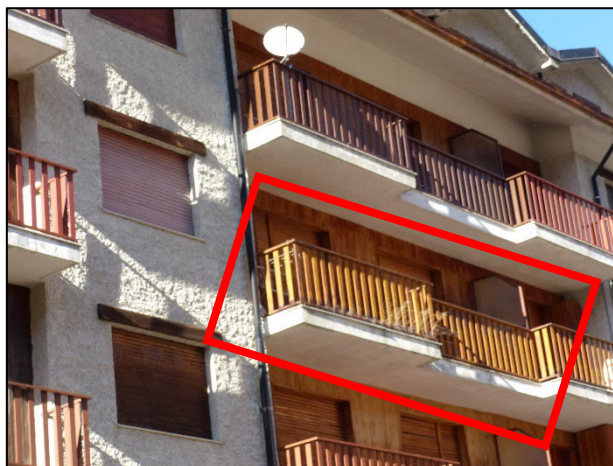
Fotografia n. 2 - Alloggio n. 730 sub 7
