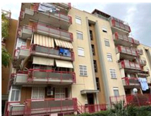
Facciata prospiciente l'atrio interno
