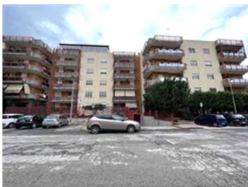
Facciata prospiciente Via Zanardelli
