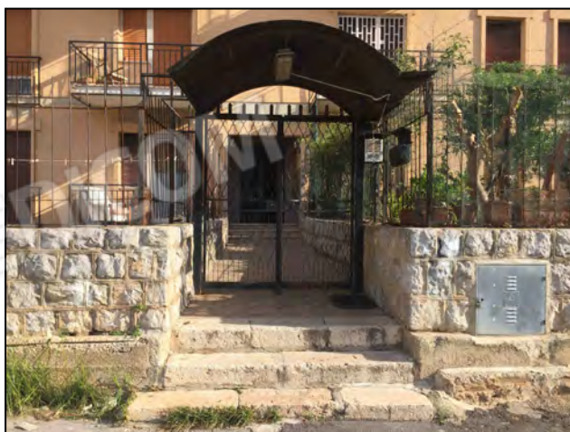
Ingresso scala C civico n.3
