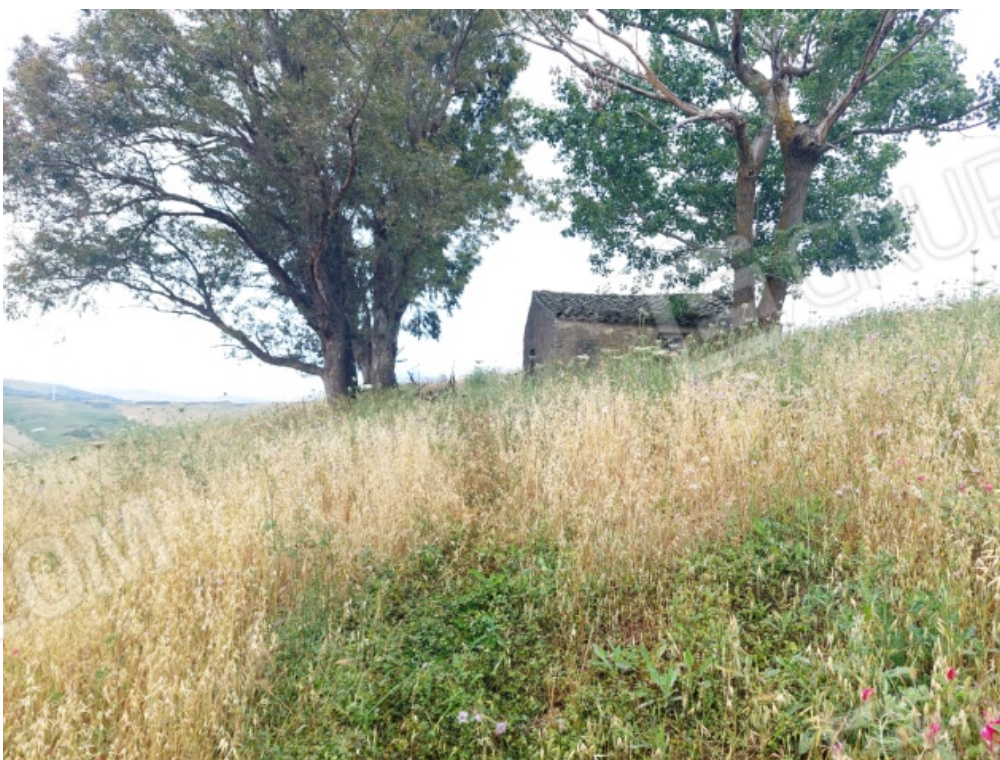
Foto 14 – Manufatto su p.lla 173
