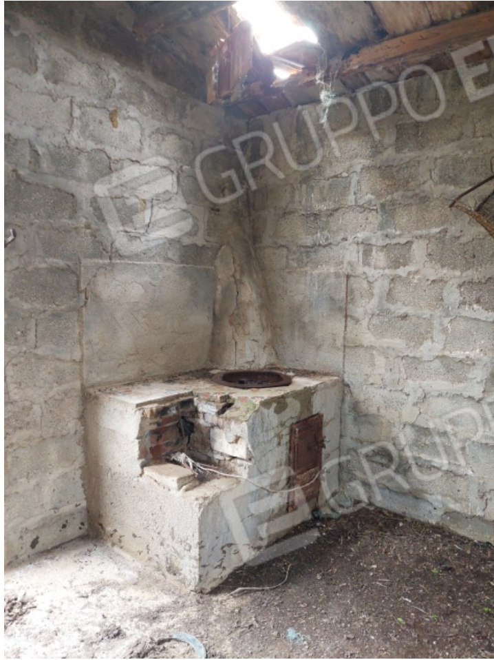
Foto 23 - Manufatto su p.lla 175
