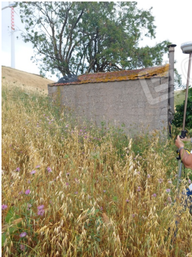
Foto 26 - Manufatto su p.lla 175
