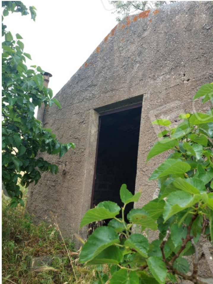
Foto 22 - Manufatto su p.lla 175
