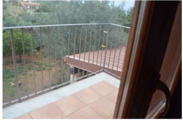
Foto 12 (vista esterna da camera da letto matrimoniale)
