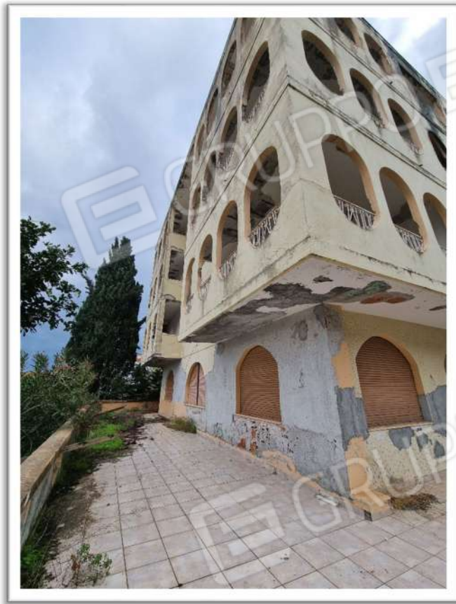
Foto 5 – Particolare terrazzo piano terra lato Sud
