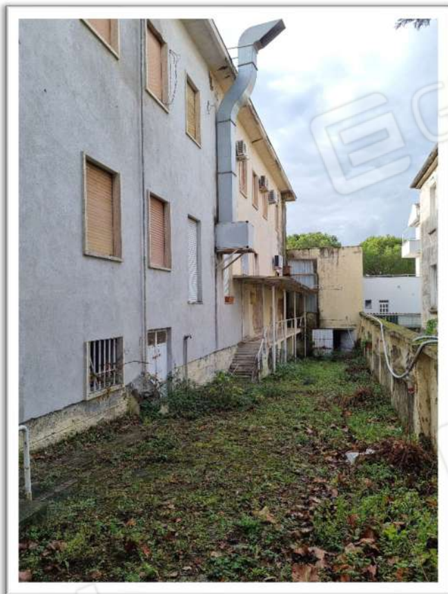
Foto 8 – Particolare prospetto Nord “primo corpo di fabbrica”
