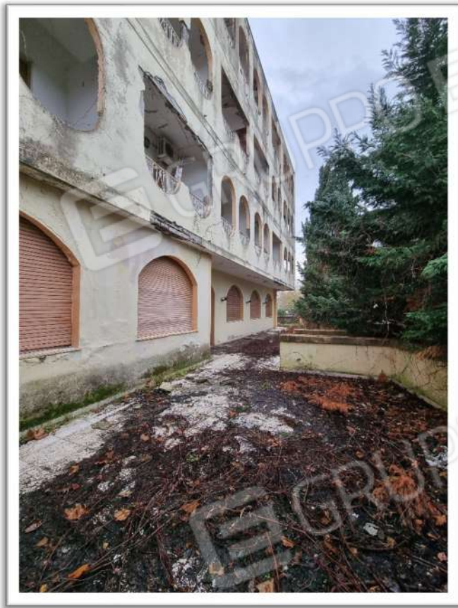
Foto 7 – Particolare terrazzo piano terra lato Ovest
