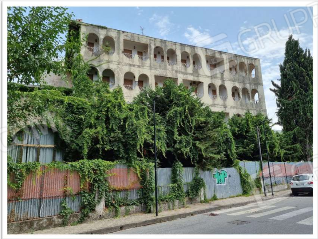
Foto 2 - Vista prospetto Ovest
