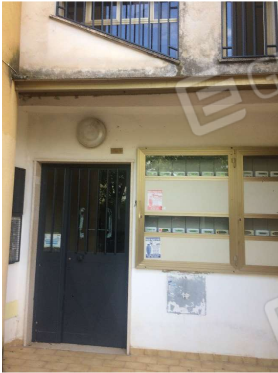
INGRESSO FABBRICATO E/4 SCALA A
