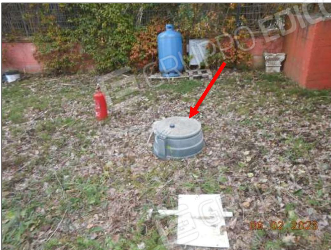
**FOTO N. 07** Vista del serbatoio di GPL interrato, posto nell'area a giardino.
