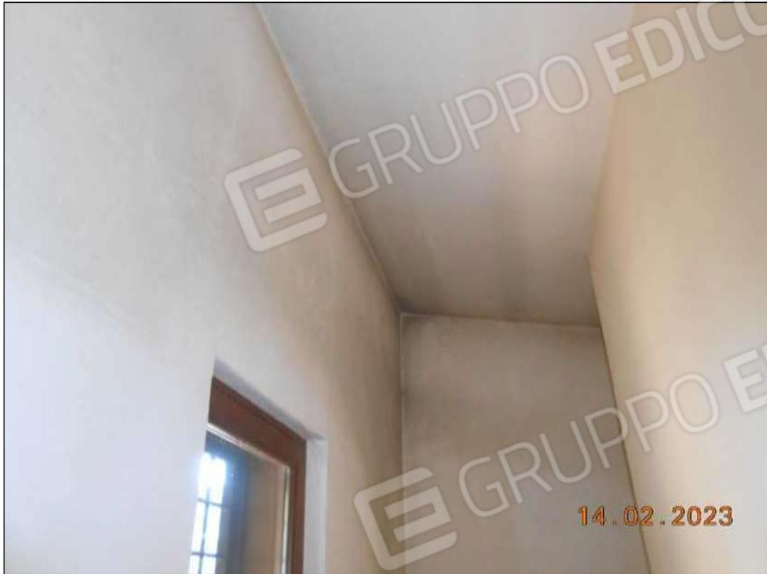
**FOTO N. 75** Vista scala interna di collegamento tra i piani. Si notano macchie di condensa e muffa di colore nero sulle pareti.
