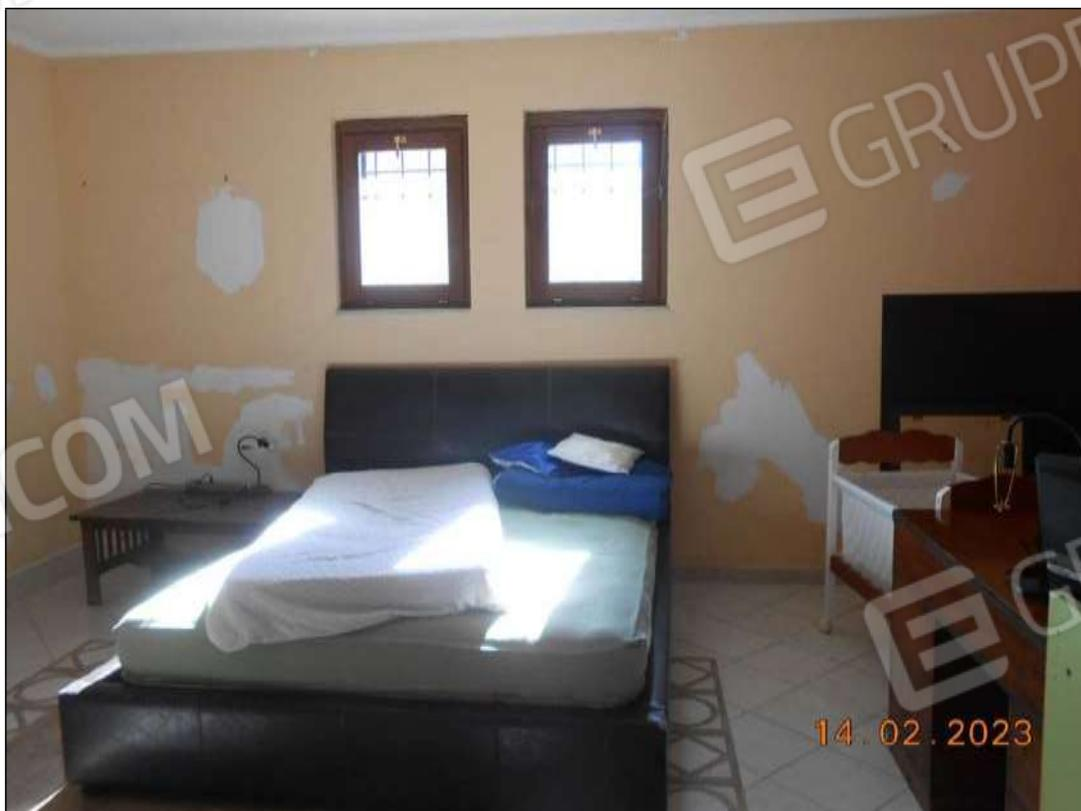
FOTO N. 60 Vista interna del piano terra. Si nota l'umidità sulle pareti.
