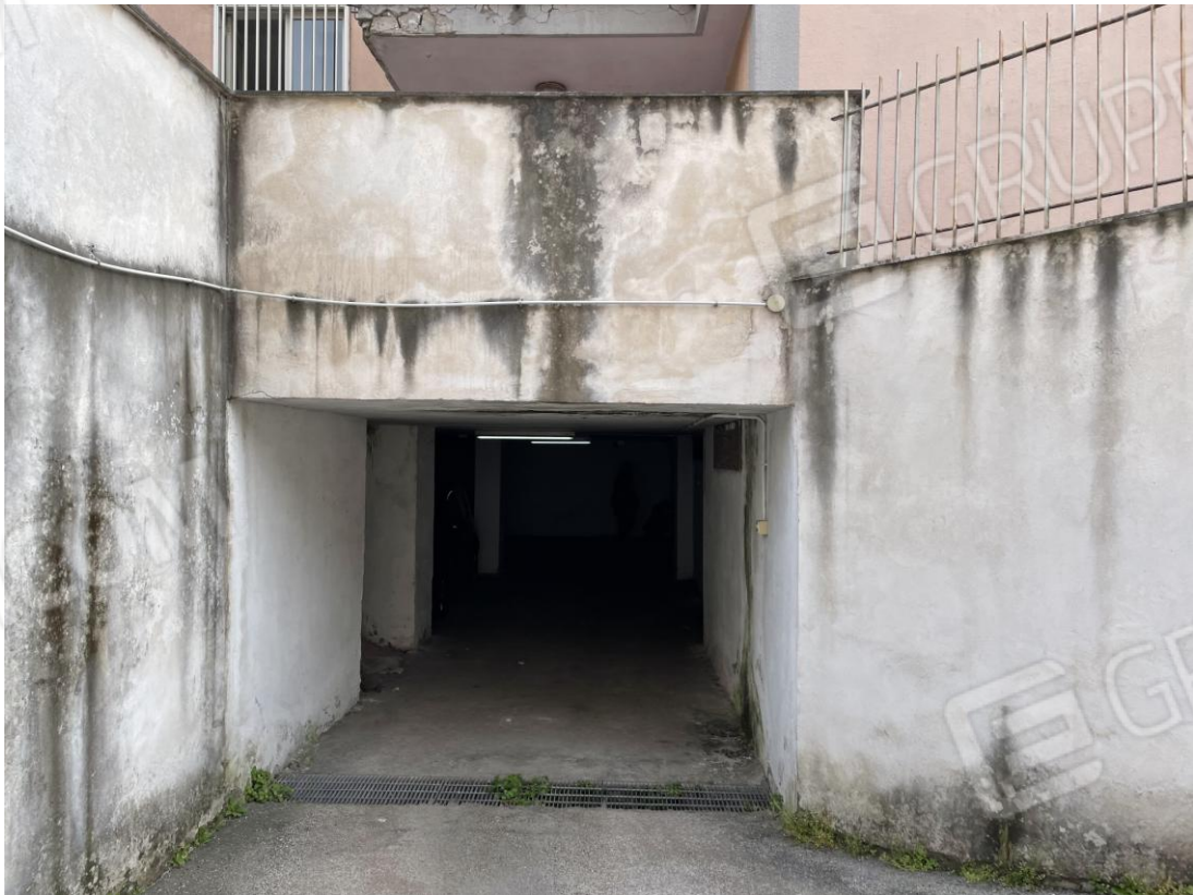
Foto F Casalnuovo di Napoli _Ingresso carrabile al piano seminterrato
