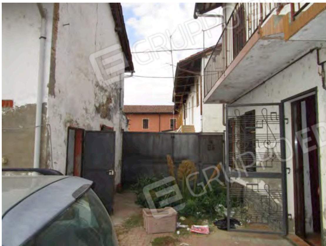
8. Accesso carraio al mappale 2139, lato cortile.
