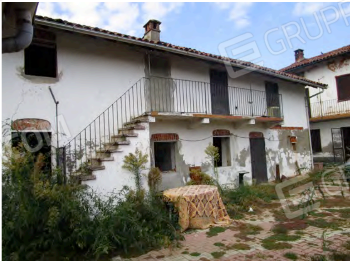
45. Fabbricato visa lato est.
