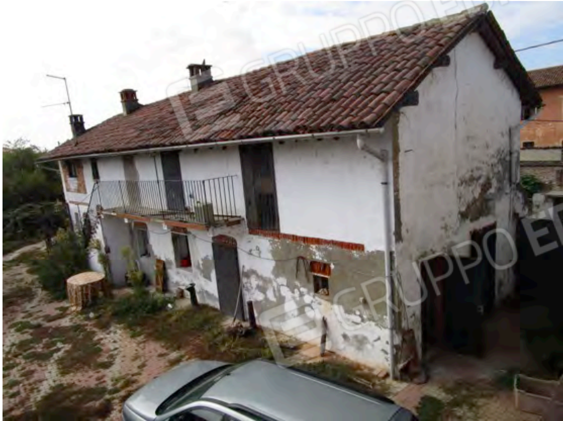
44. Fabbricato visa lato nord-est.
