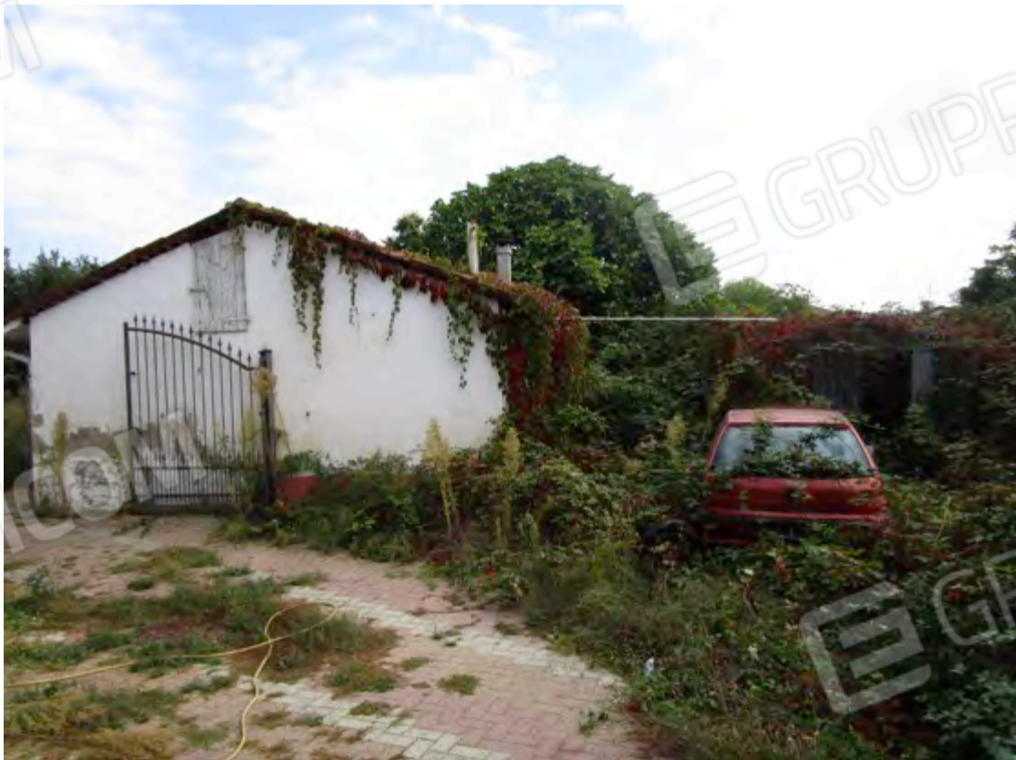
86. Autorimessa lato ovest, accesso al locale deposito sottotetto.
