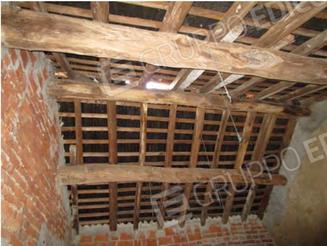
76. Dettaglio del tetto.
