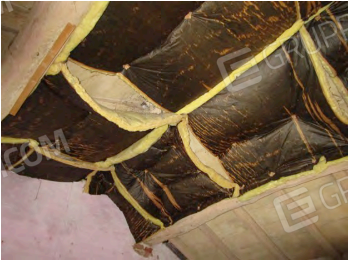
77. Dettaglio del tetto.
