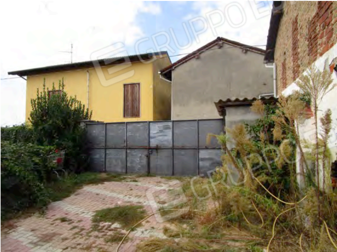
14. Accesso carraio al mappale 1017, lato cortile.
