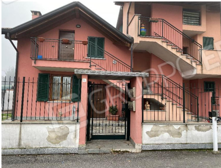
FOTO 5: ingresso pedonale – via Paganini n. 1/A
