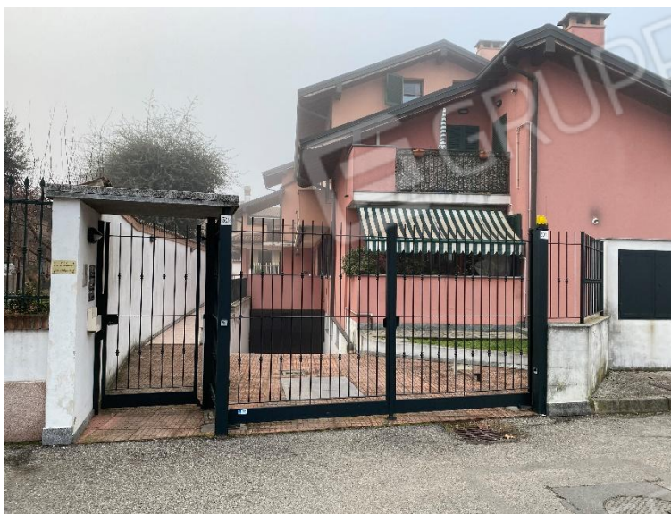
FOTO 6: ingresso carraio – via della Folletta n. 30/A
