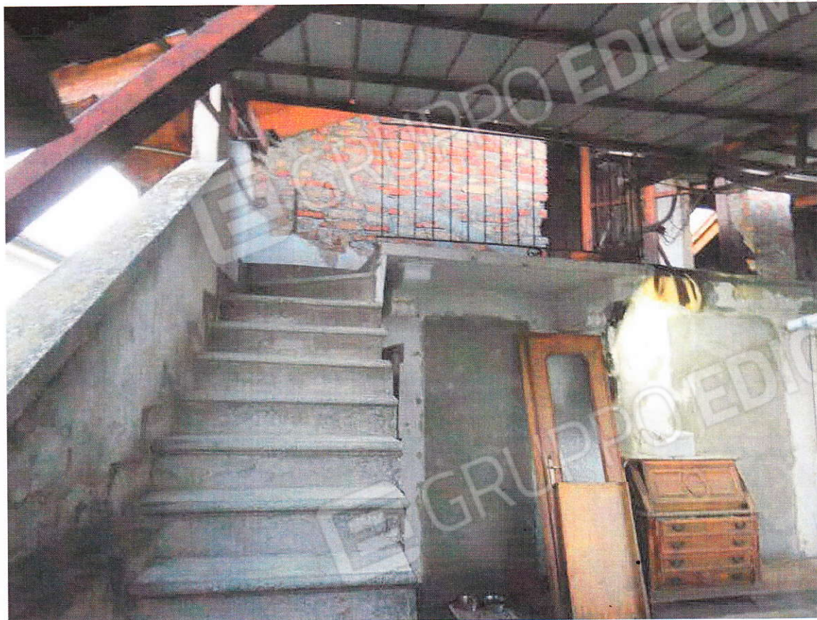
Scala di accesso dal piano primo al piano secondo
