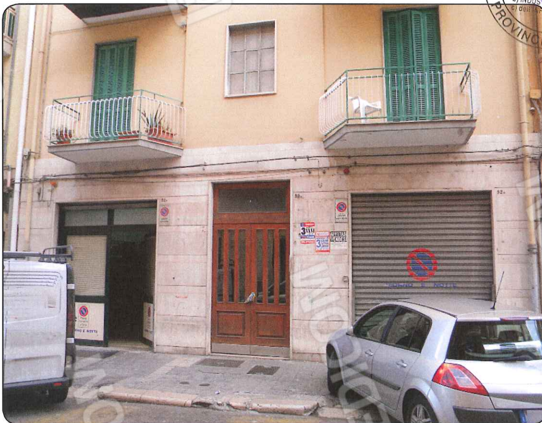
Foto 2: Edificio in Bari, via Indipendenza n. 52/F-G-H - vista ovest
