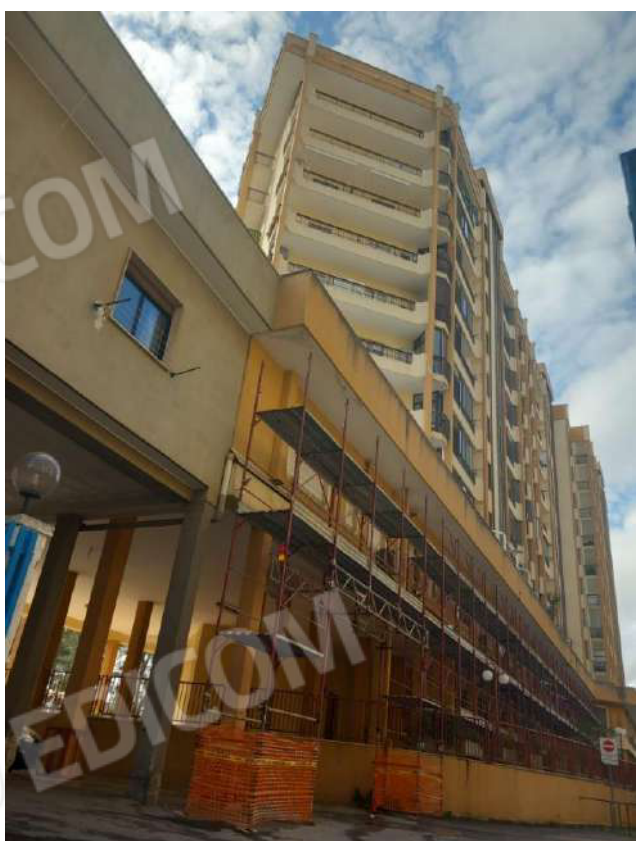
Foto 51 – Prospetto posteriore su aree condominiali
