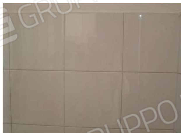
Foto 77 – Particolare rivestimento parete del vano ripostiglio
