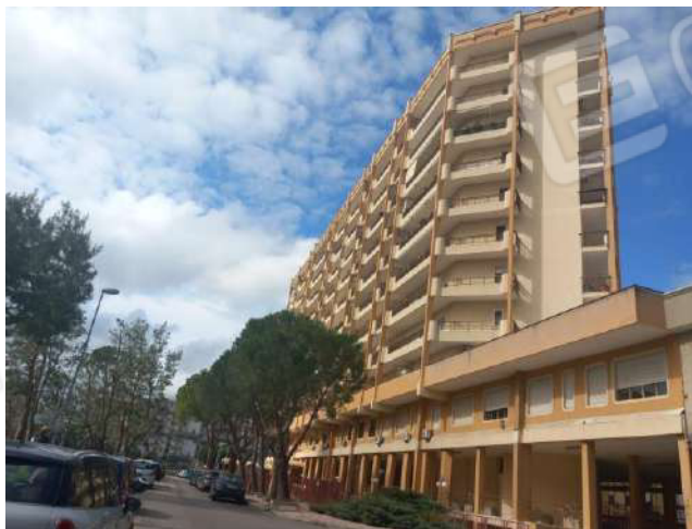
Foto 49 – Vista sull'edificio – prospetto su via Santi Cirillo e Metodio
