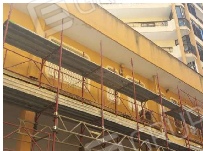
Foto 52 – Prospetto posteriore – particolare finestre
