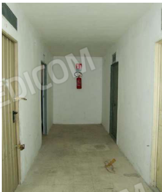
Foto 83 - Vista del corridoio condominiale d'accesso alla cantinola
