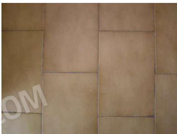
Foto 76 – Particolare pavimentazione del vano ripostiglio
