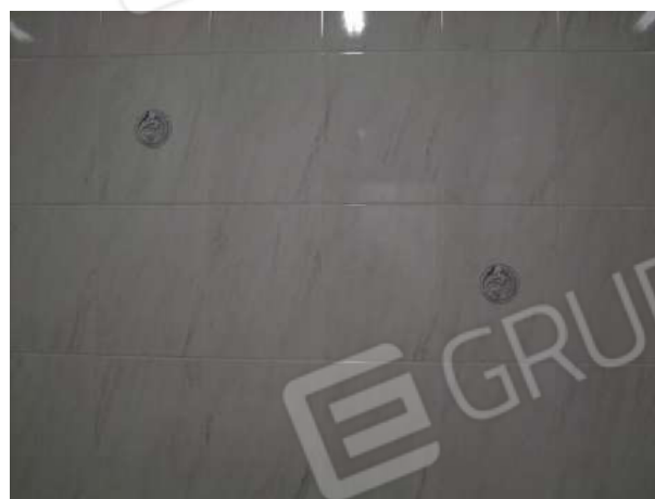
Foto 79 – Particolare rivestimento bagno
