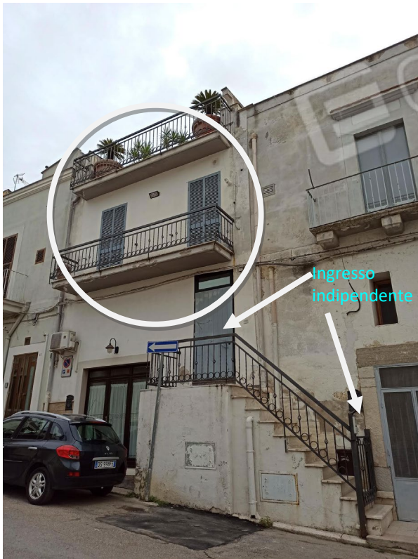
Foto 01 - Vista dell'ingresso dal C/so Traiano
