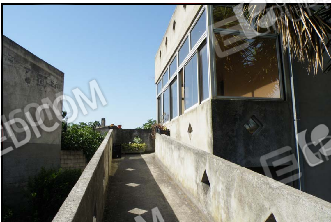
FOTO 6 - Rampa d'ingresso e veranda chiusa al piano rialzato
