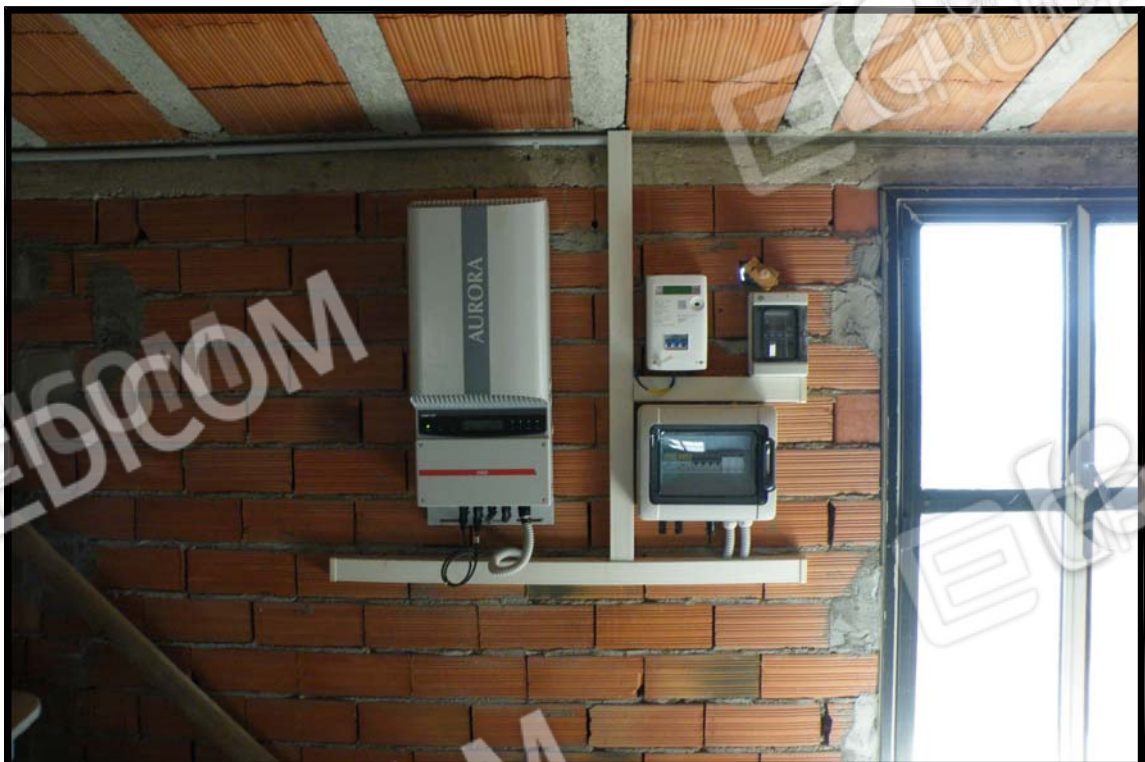
FOTO 36 - Contatore ENEL e fotovoltaico
