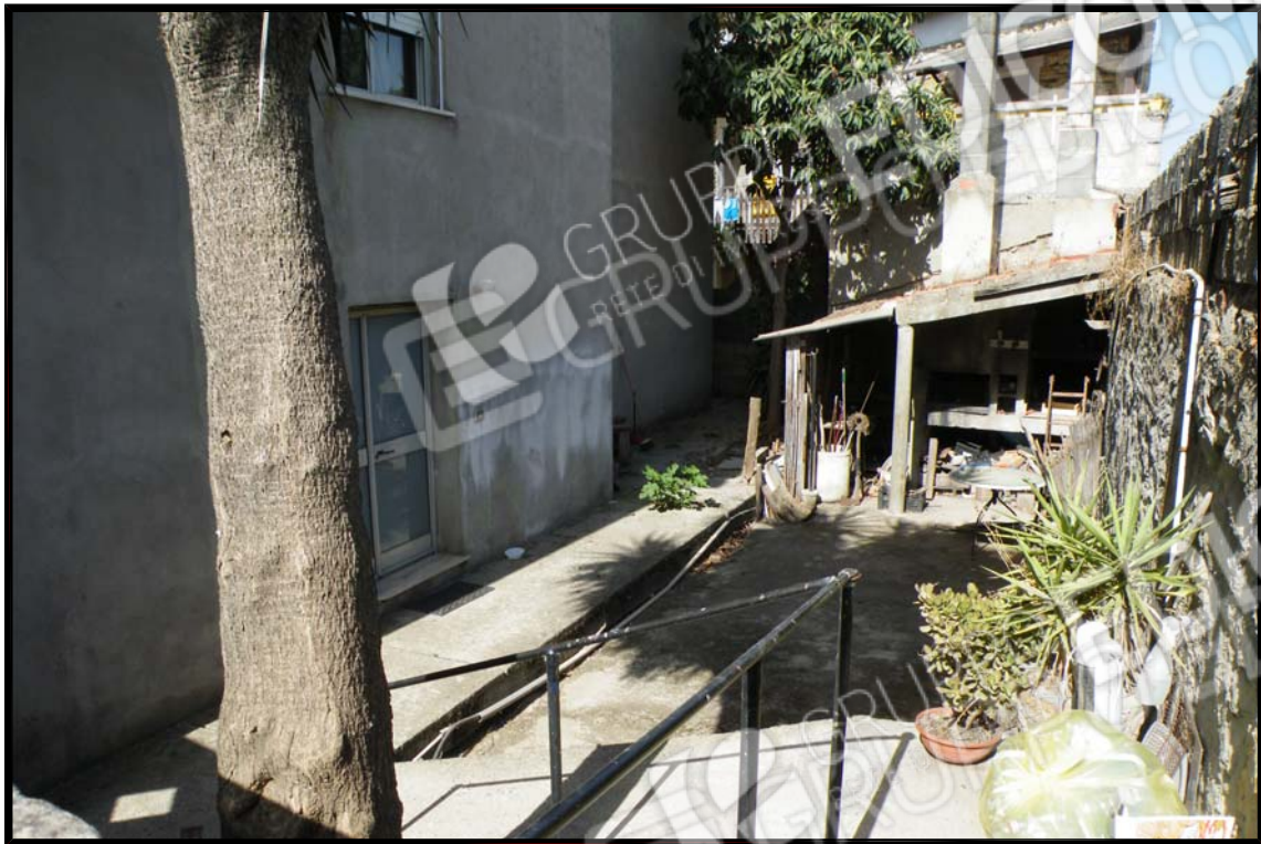
FOTO 7 - Tettoia e ingresso allo scantinato dal cortile
