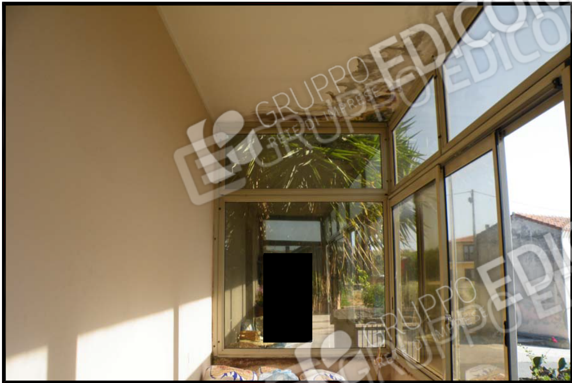
FOTO 27 - Piano rialzato: veranda chiusa 1
