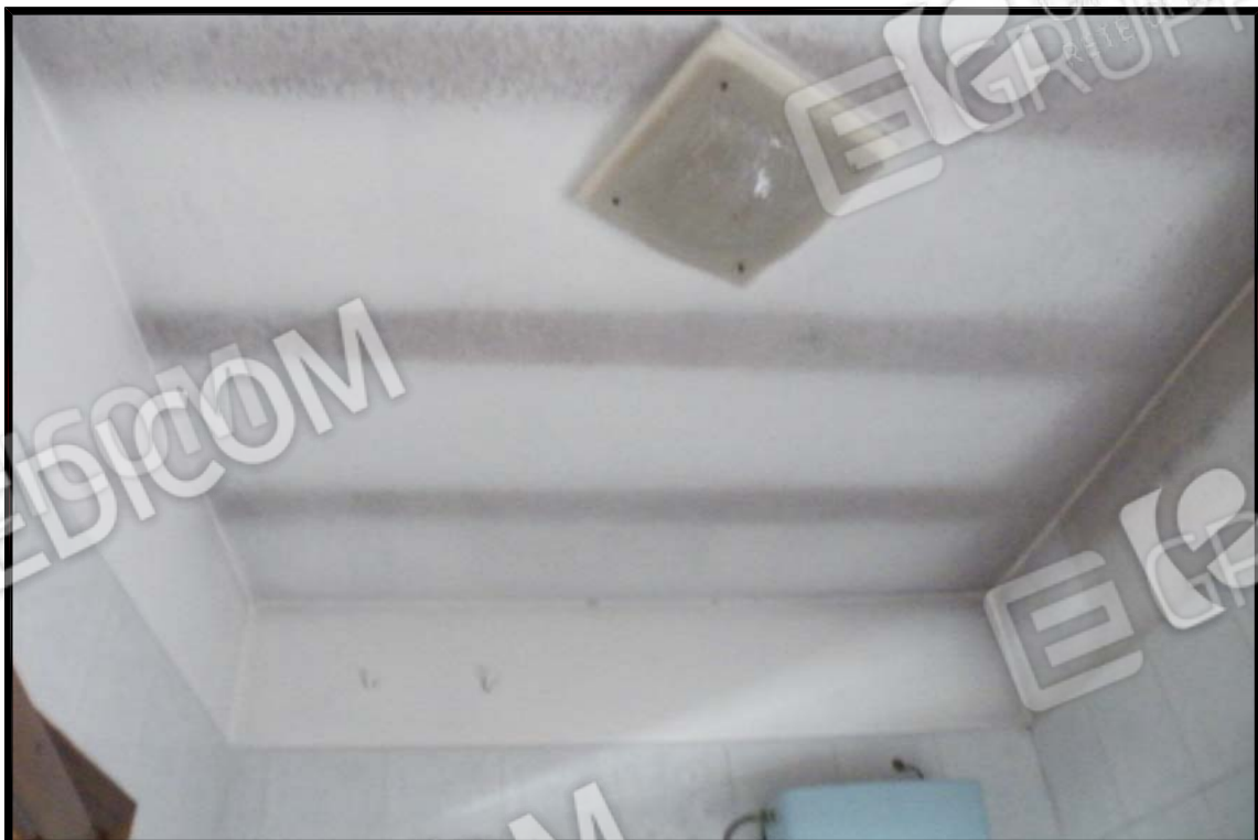
FOTO 26 - Piano rialzato: soffitto del bagno 1
