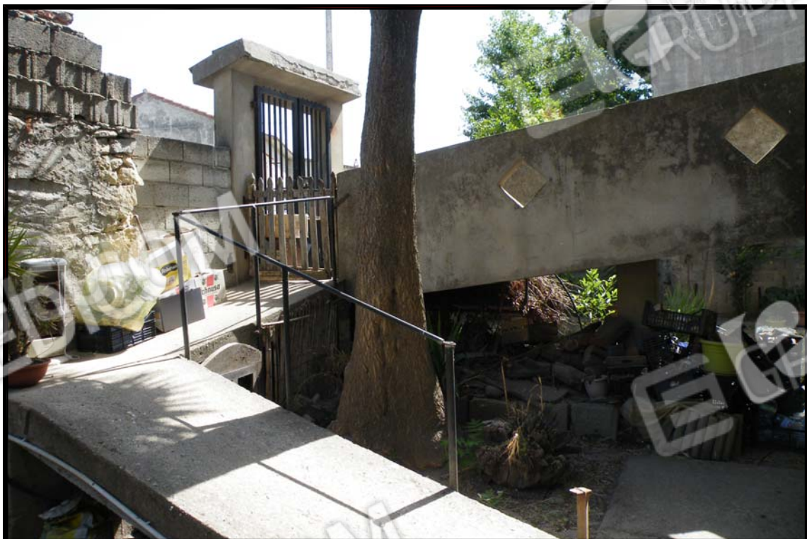
FOTO 8 - Rampa per l'accesso al cortile
