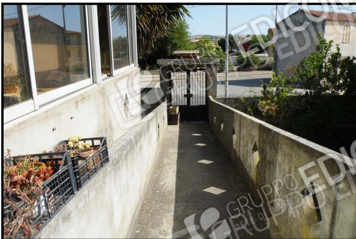
FOTO 5 - Rampa d'ingresso piano rialzato
