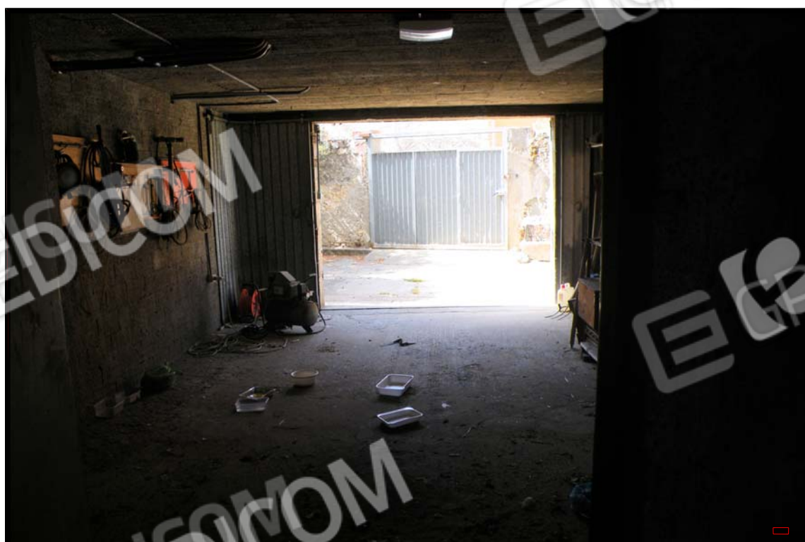
FOTO 18 - Garage: lato interno serranda d'ingresso
