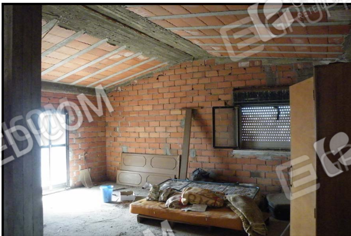
FOTO 32 - Sottotetto: lato Sud e accesso balcone 2
