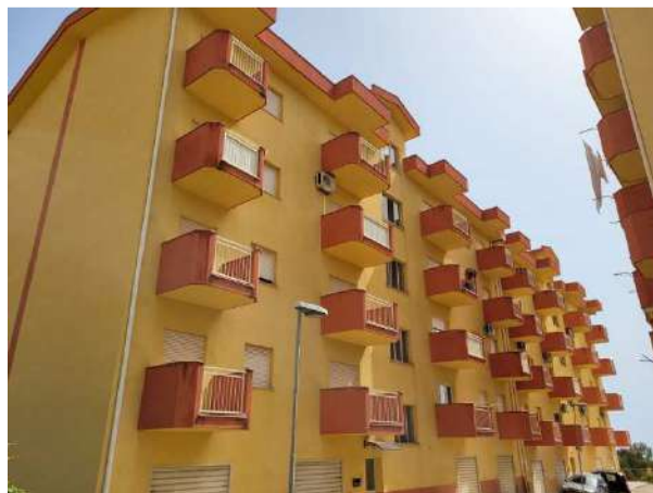
Foto del Prospetto Ovest
