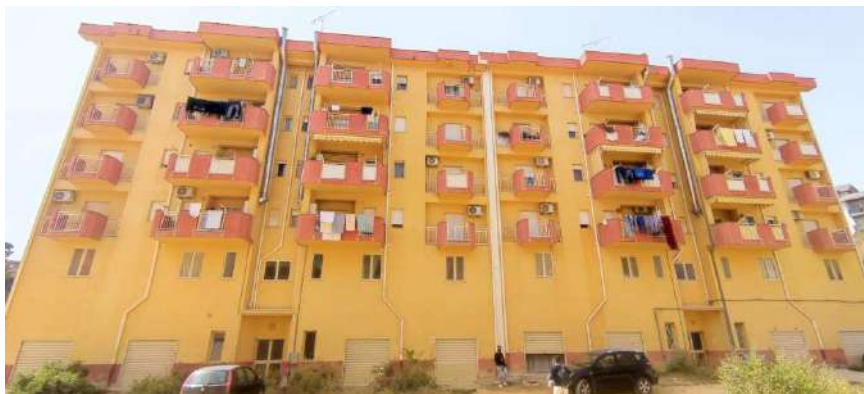
Foto del Prospetto Est
