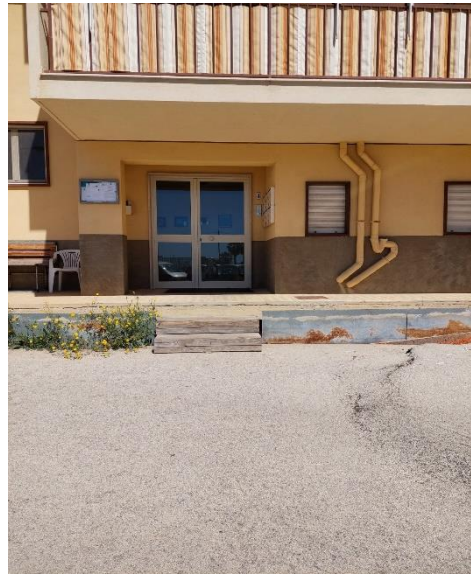
Foto n°2 Ingresso civ. n. 4
