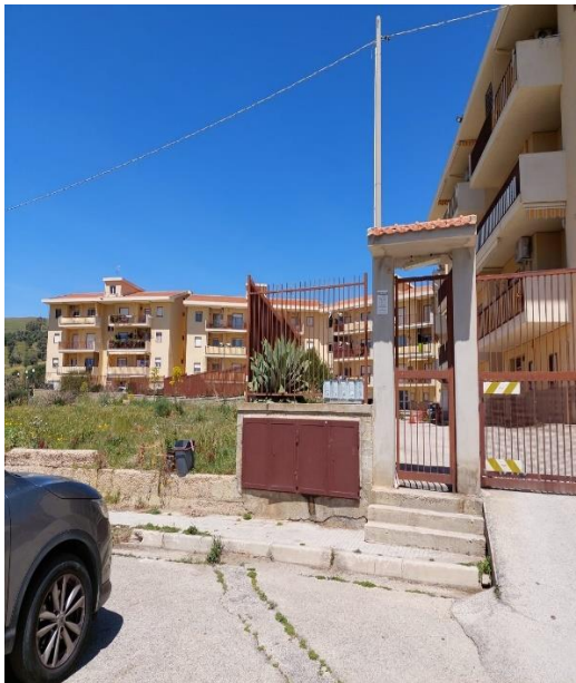
Foto n°3 Cannello esterno complesso edilizio
