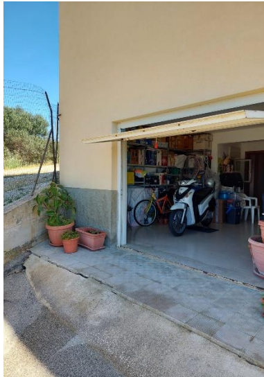
Foto n°17 Serranda accesso box auto
