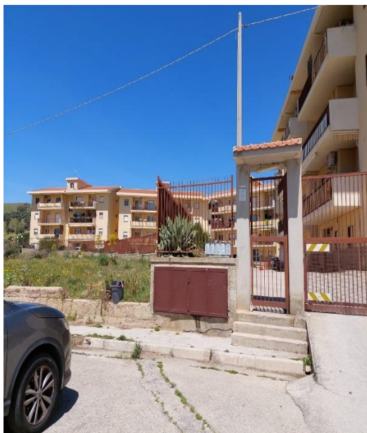
Foto n°3 Cannello esterno complesso edilizio
