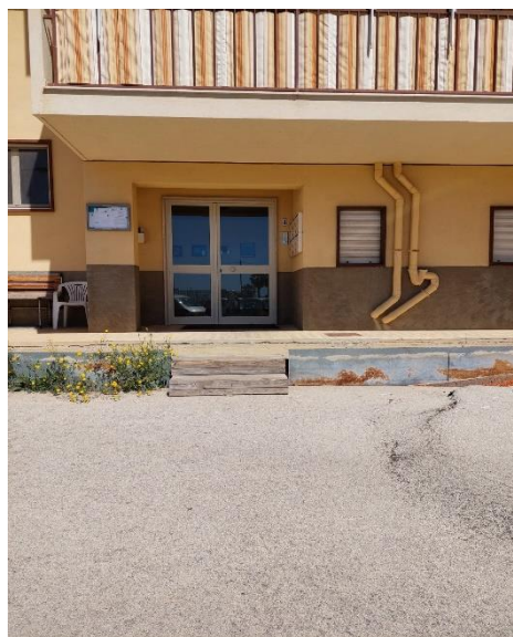
Foto n°2 Ingresso civ. n. 4
