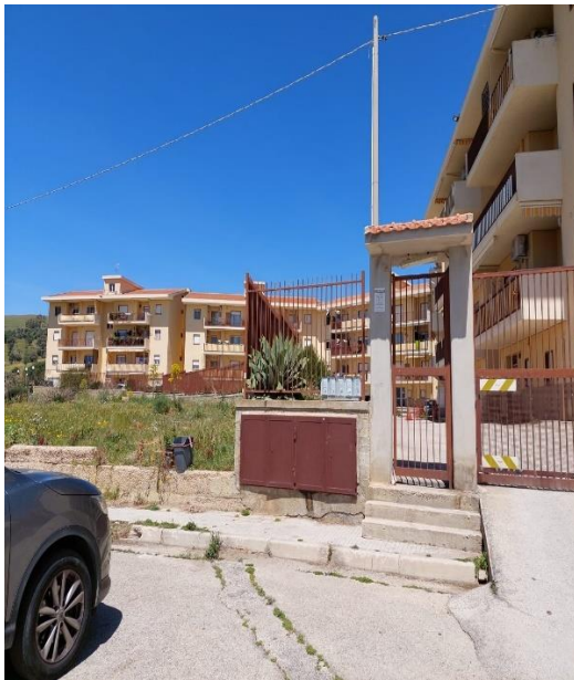
Foto n°3 Cannello esterno complesso edilizio
