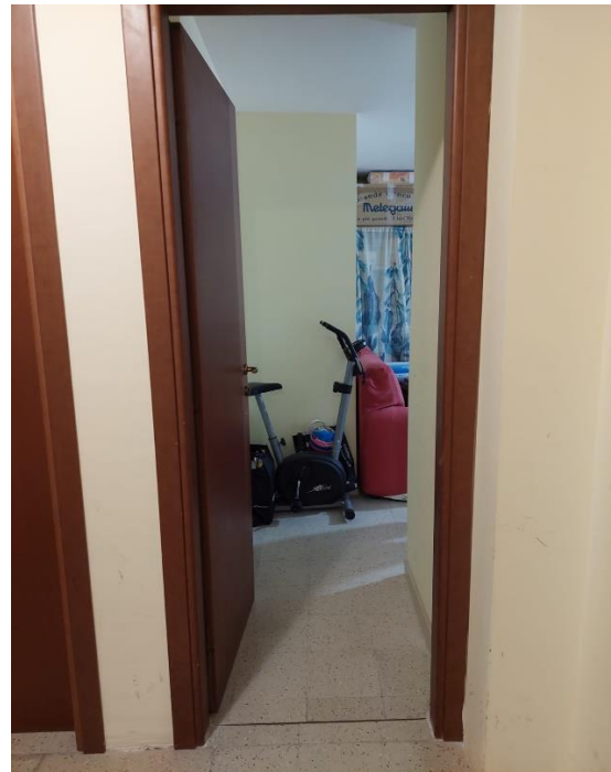
Foto n° 18 Porte di accesso box
