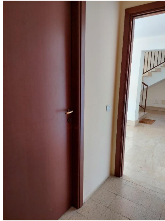
Foto n° 18 Porta di accesso cantinola
