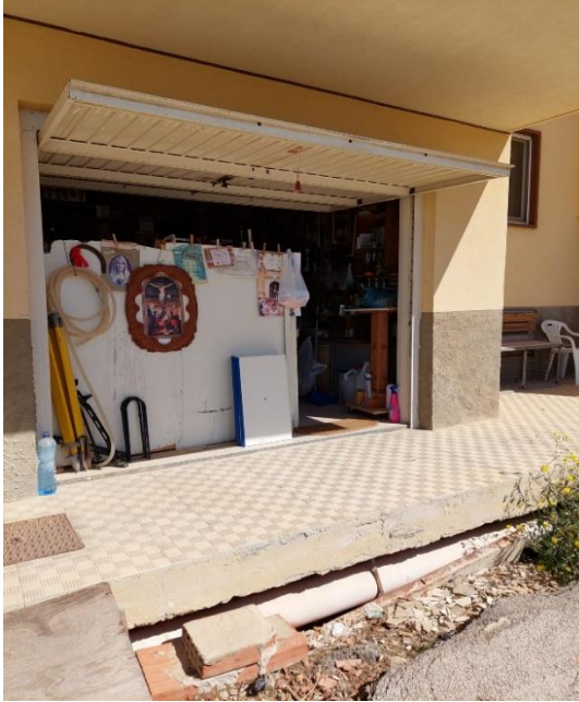
Foto n° 17 Serranda accesso box auto
