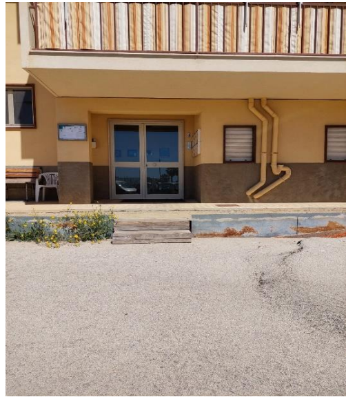
Foto n°2 Ingresso civ. n. 4
