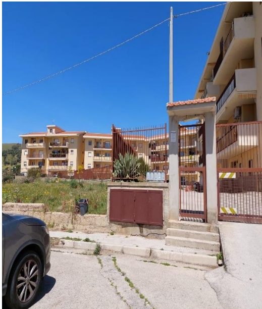
Foto n°3 Cannello esterno complesso edilizio
