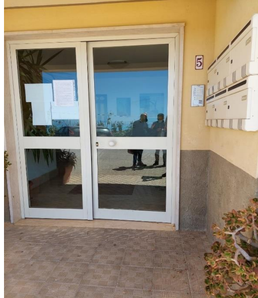
Foto n°2 Ingresso civ. n. 5
