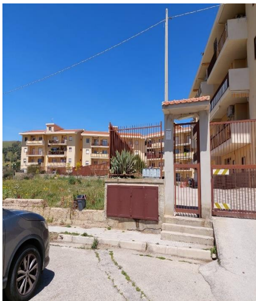
Foto n°3 Cancelli esterni complesso edilizio
