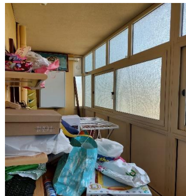
Foto n° 16 chiusura balcone lato nord
