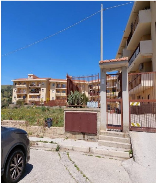
Foto n°3 Cancelli esterni complesso edilizio
