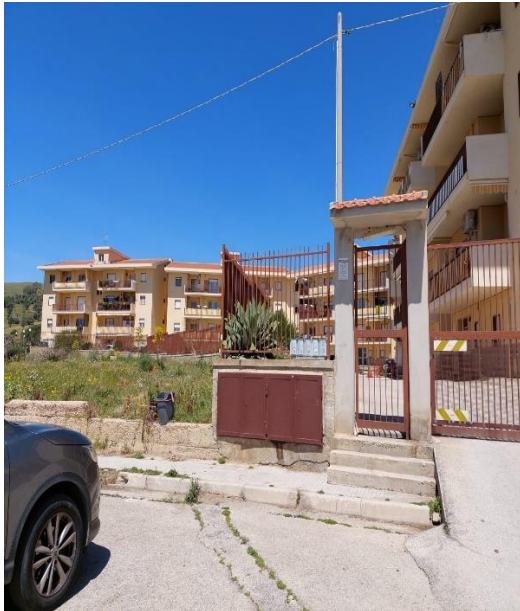
Foto n°3 Cancelli esterni complesso edilizio
