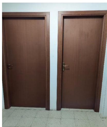
Foto n° 19 Porta interna di accesso
