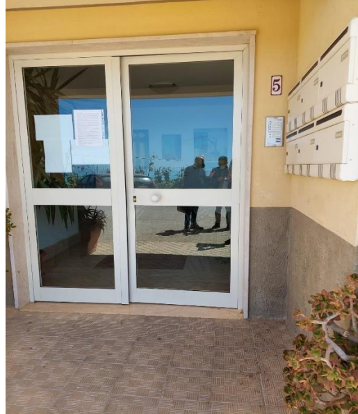
Foto n°2 Ingresso civ. n. 5
