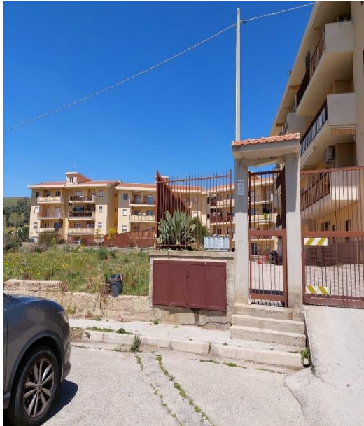
Foto n°3 Cannello esterno complesso edilizio
