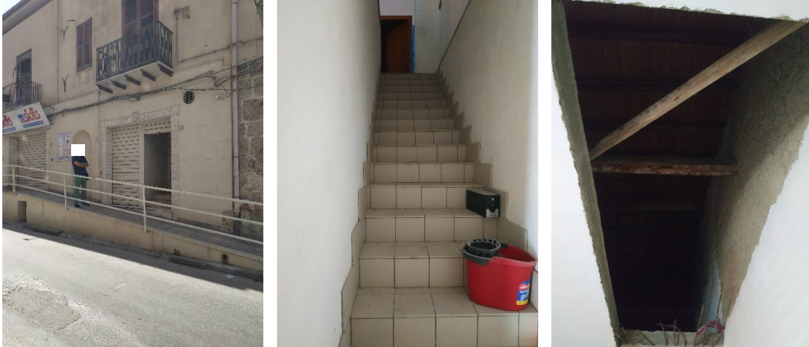
Figura 7 – A sinistra vano di accesso al piano primo, al centro il vano scala ed a sinistra botola per accesso al sottotetto
