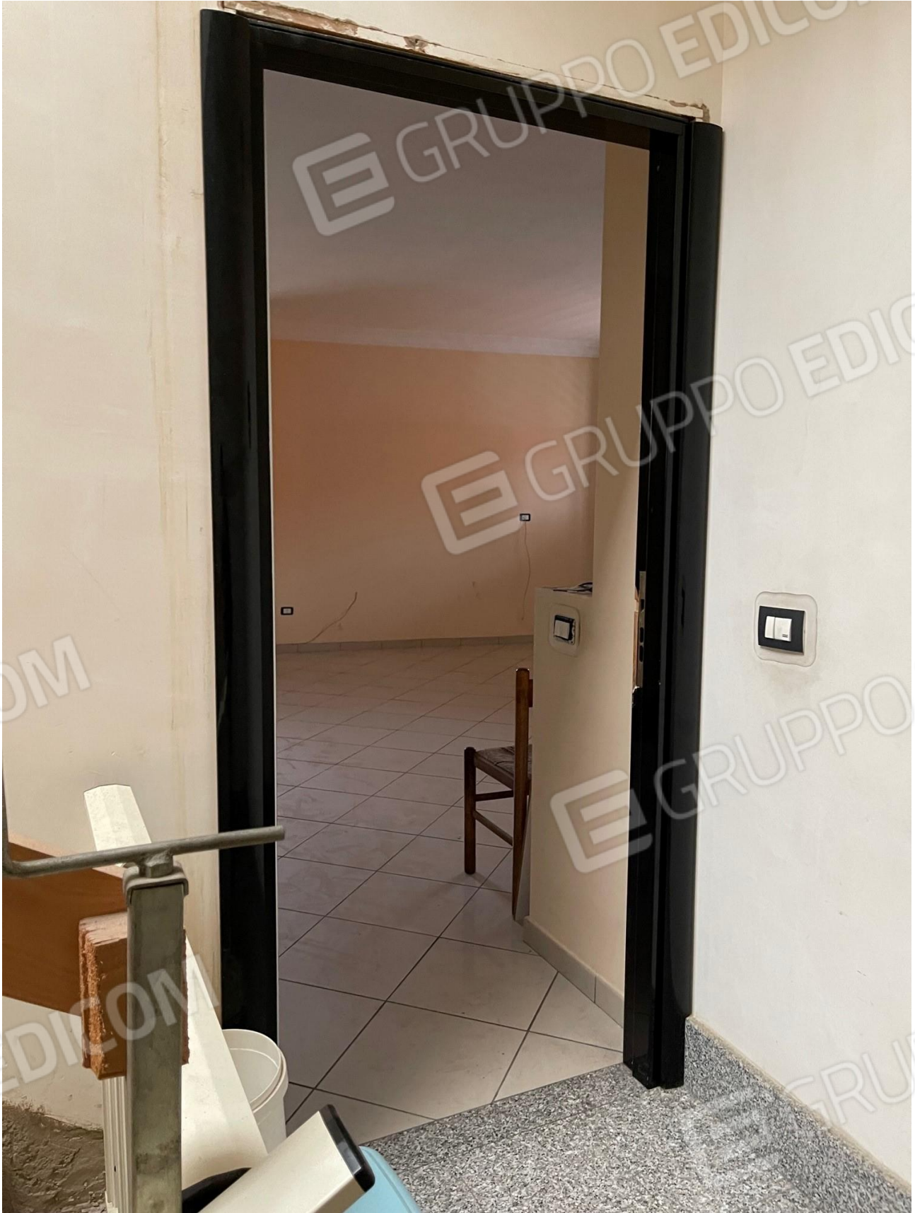
Foto 4 - Porta d'ingresso al piano secondo
