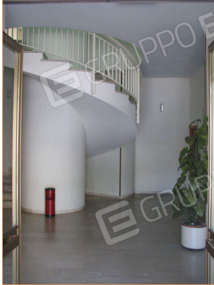
Foto 3 - Vista interna - Ingresso Piano Terra
