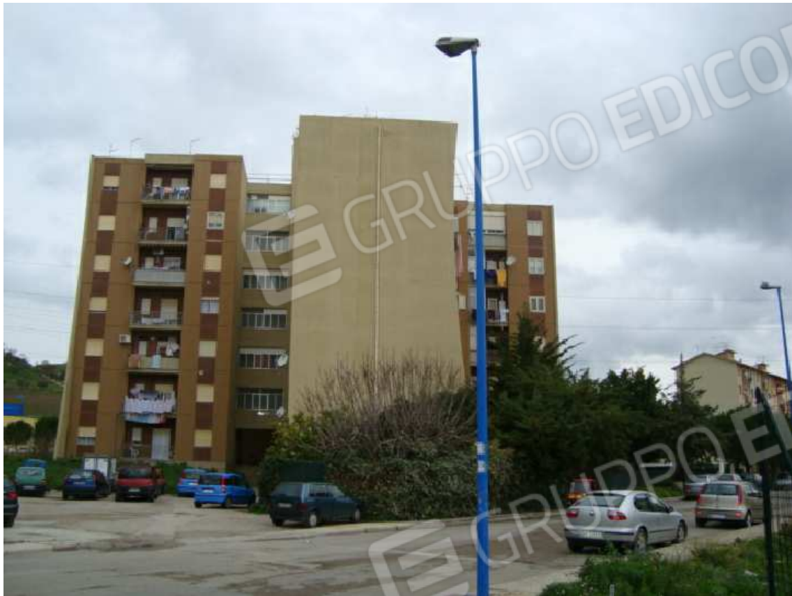
Foto n. 1: Prospetto torre otto lato sud-est (via Aldo Moro)
