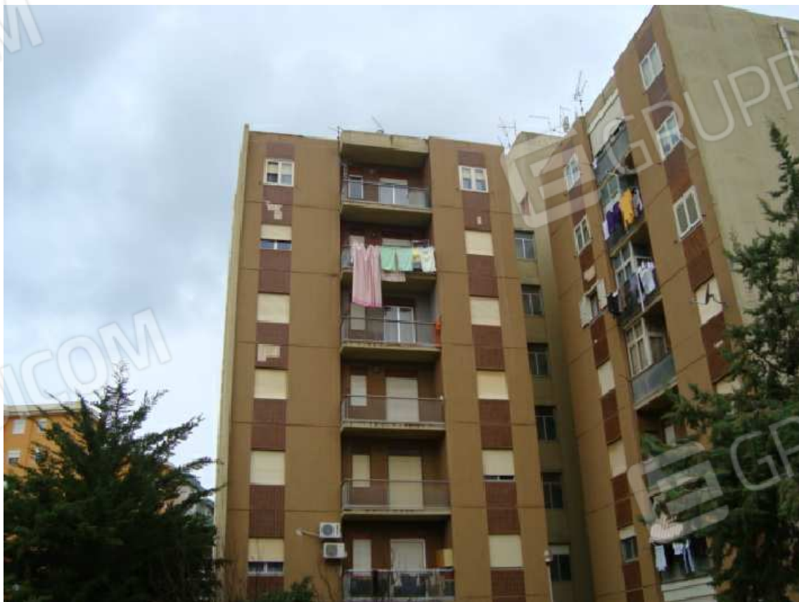
Foto n. 2: Prospetto torre otto lato nord-ovest (dal piazzale interno)
