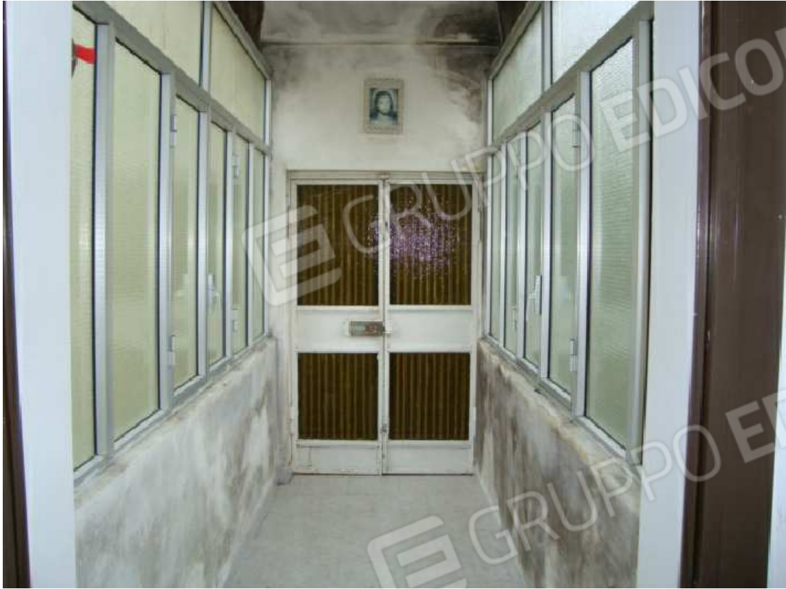
Foto n. 15: Foto interna del collegamento tra la scala condominiale e l'ingresso all'appartamento
