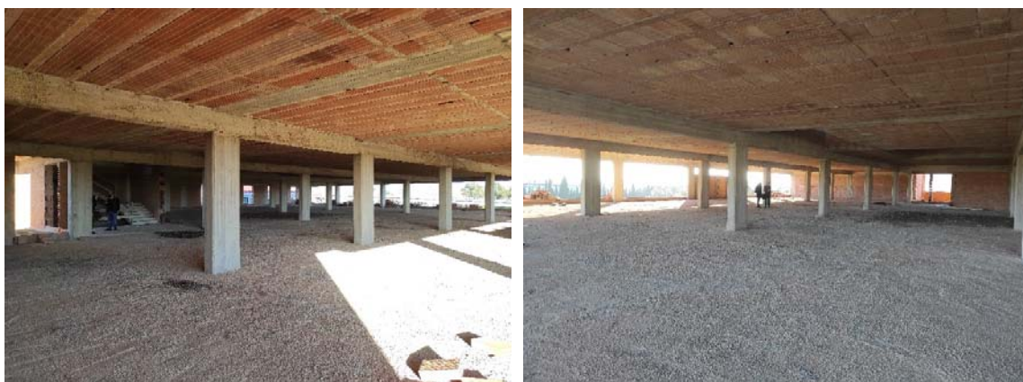
Figura 10 – viste interne del piano primo
