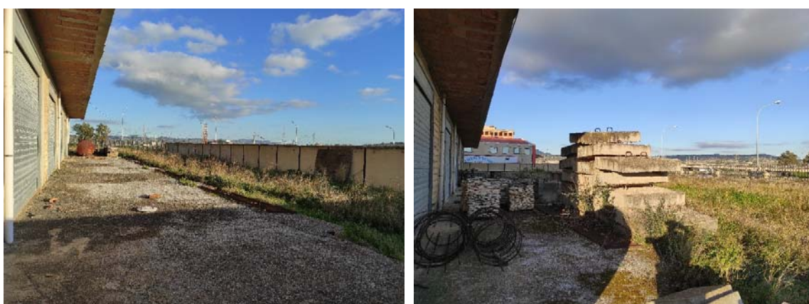
Figure 17 – Viste esterna terrazza area di corte (sub 1)
