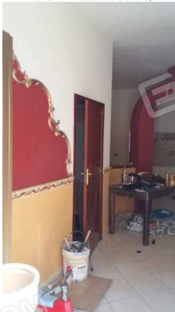
FOTO 8 - Veduta del wc a piano terra.
