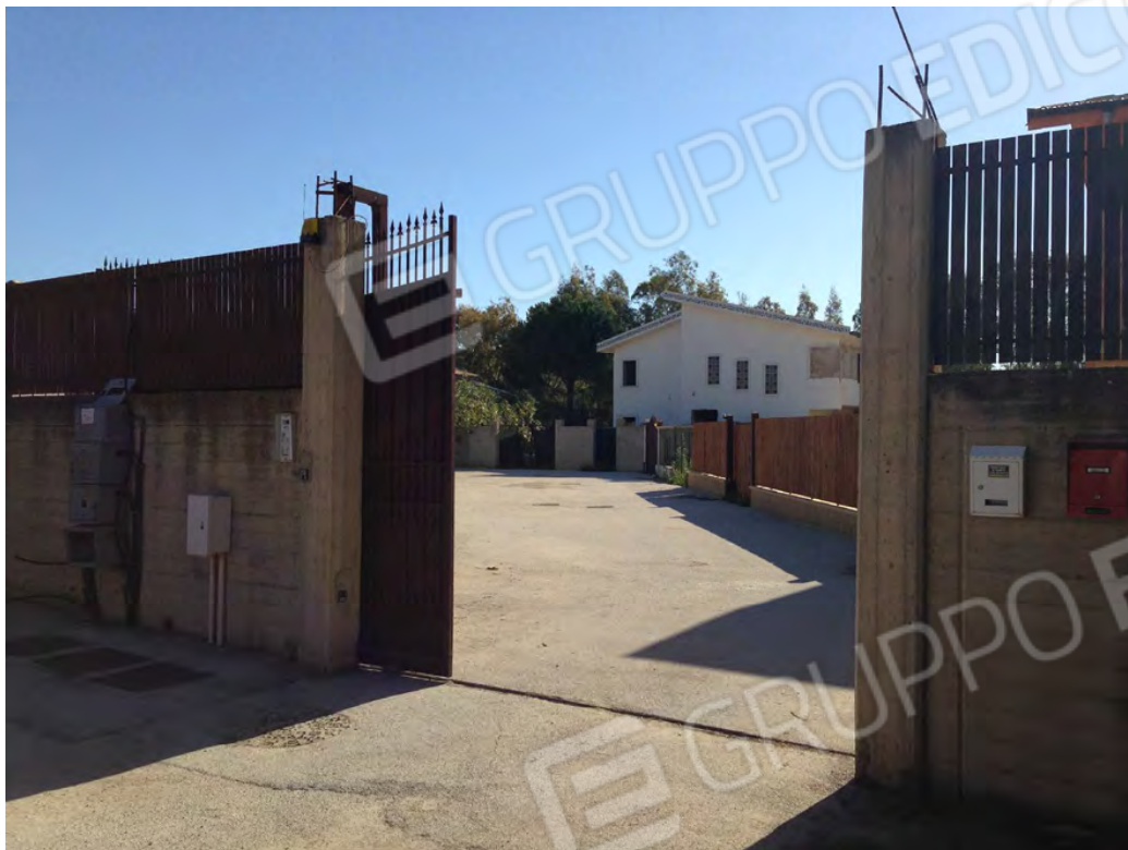
Prospetto lato via del Sole (piano terra e primo) senza civico e cancello condominiale su vialetto identificato al fg. 19 part. 1588
