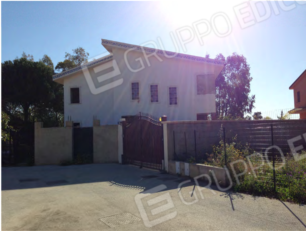
Prospetto lato via del Sole (piano terra e primo) su vialetto identificato al fg. 19 part. 1588
