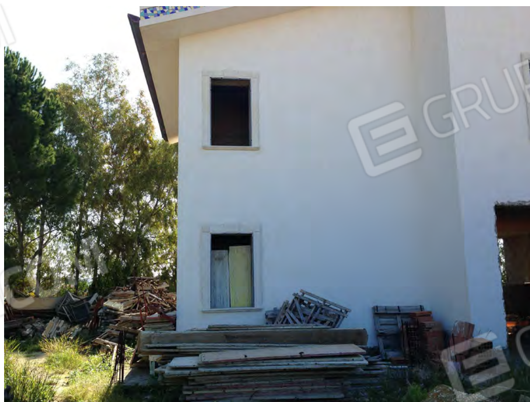
Particolare rifinitura prospetti (piano terra e primo) del fabbricato allo stato grezzo, lato via del Sole
