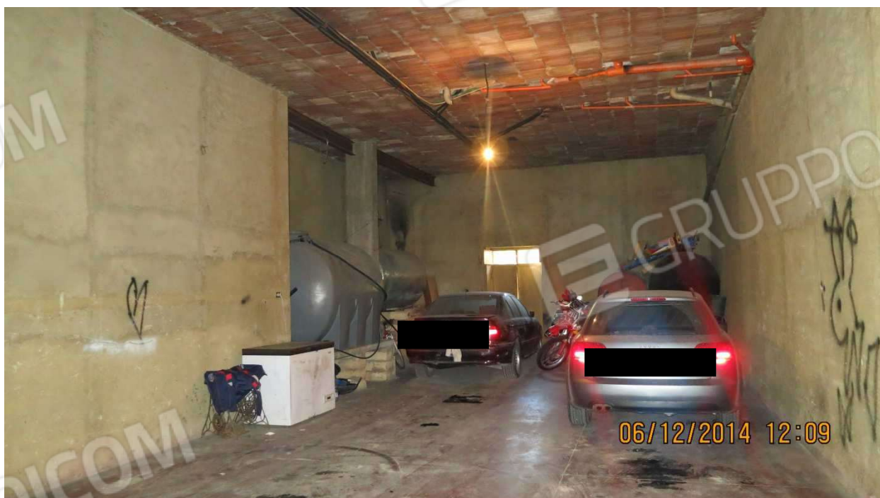
FOTO 6: Consistenza magazzino a piano terra Part.IIa 695/1 in corrispondenza del civico n. 42 di Via Brindisi. Portoncino di ingresso anche dal vano scala condominiale entrando a destra rispetto al portone di ingresso in corrispondenza al Civico n. 44 di Via Brindisi.
