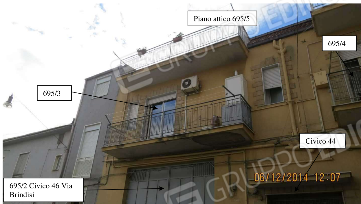
FOTO 3: Altra vista del fabbricato con evidenza sui vari sub. Al piano attico l'appartamento di cui alla Part.IIa 695/5 in testa ad altra ditta estranea alla presente procedura esecutiva.
