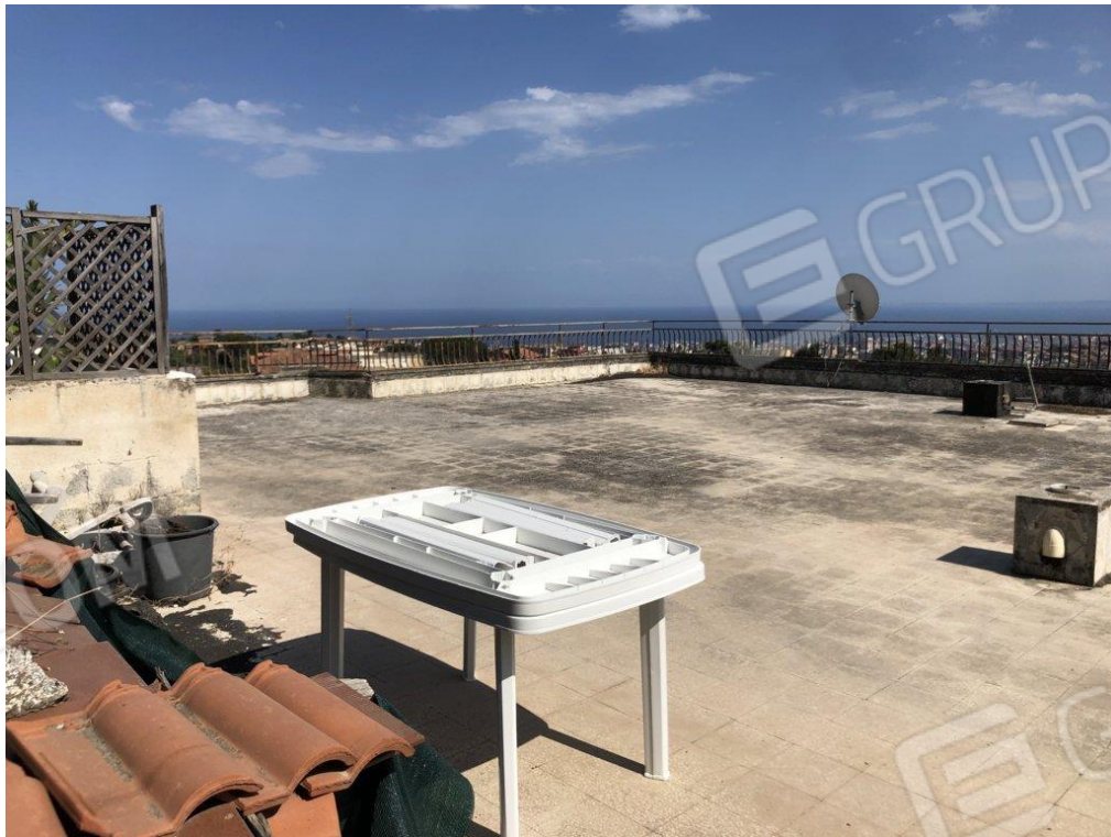
Foto n.16 Vista del lastrico solare.
