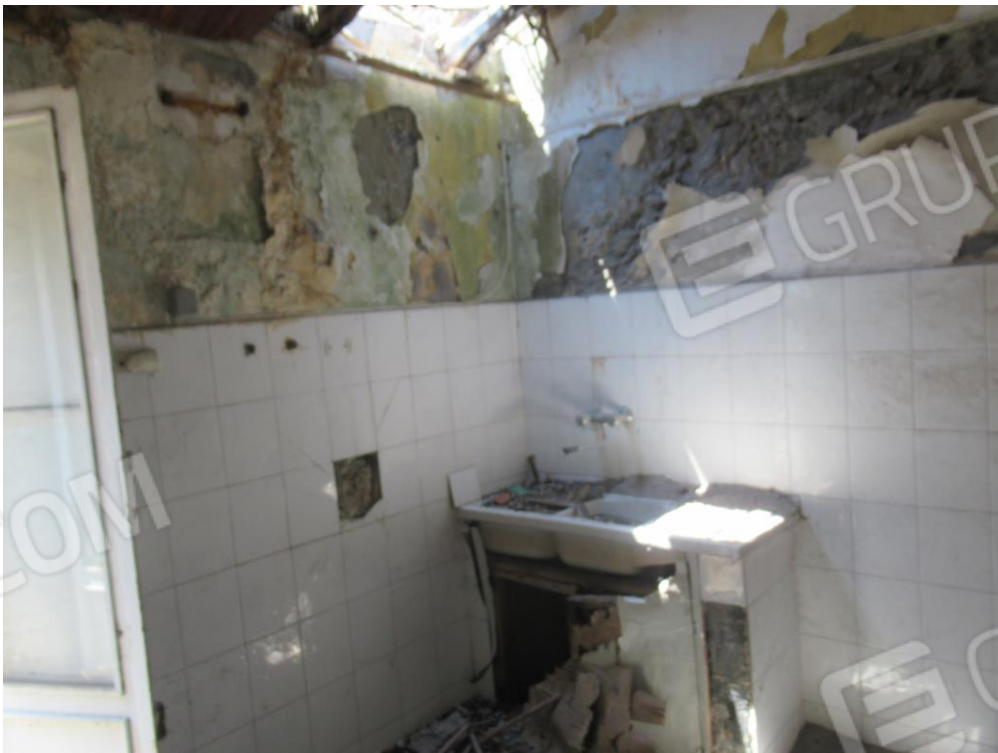
Foto n ° 14 – Zona cucina –
