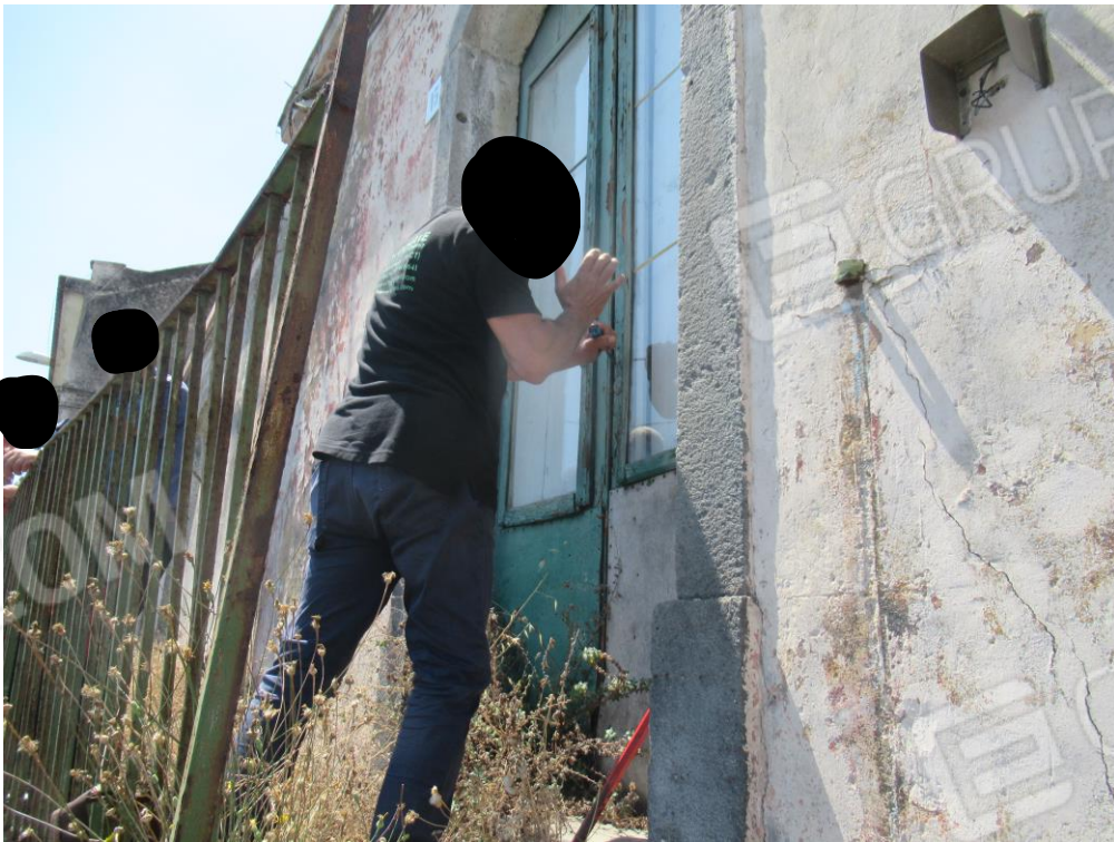
Foto n° 2 – Idem foto n° 1 –
