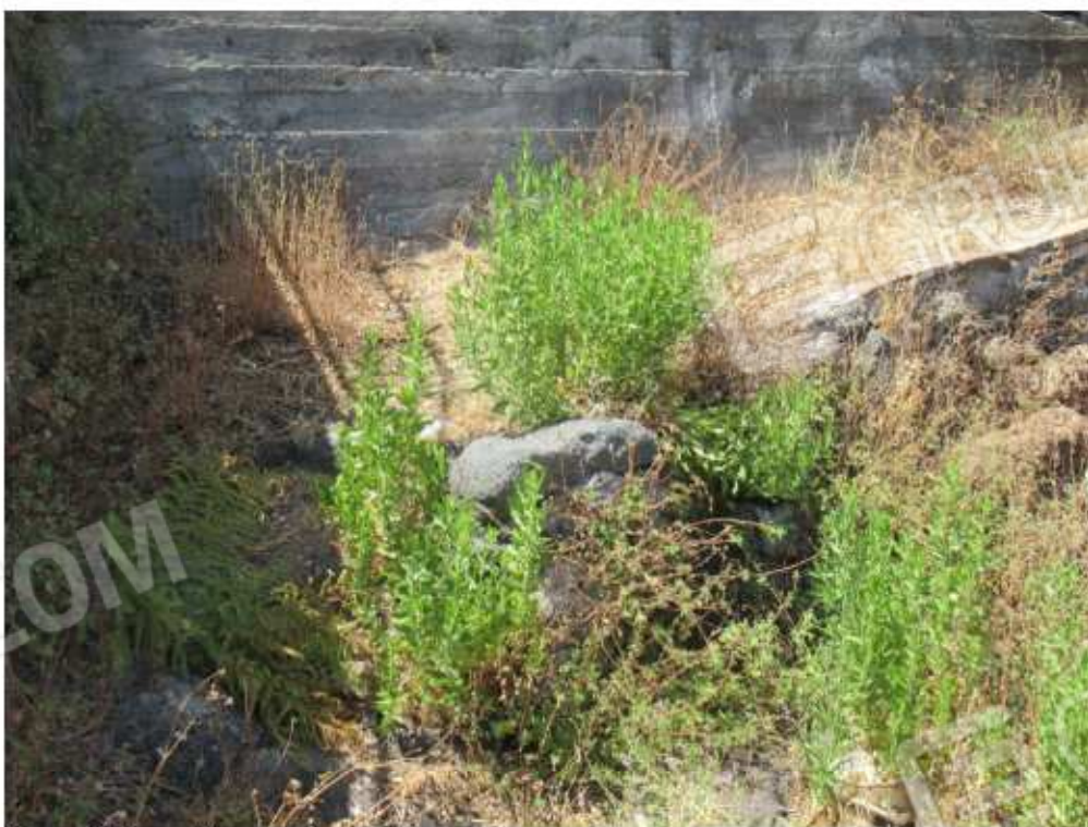
Foto n ° 16 - Zona cortile -
