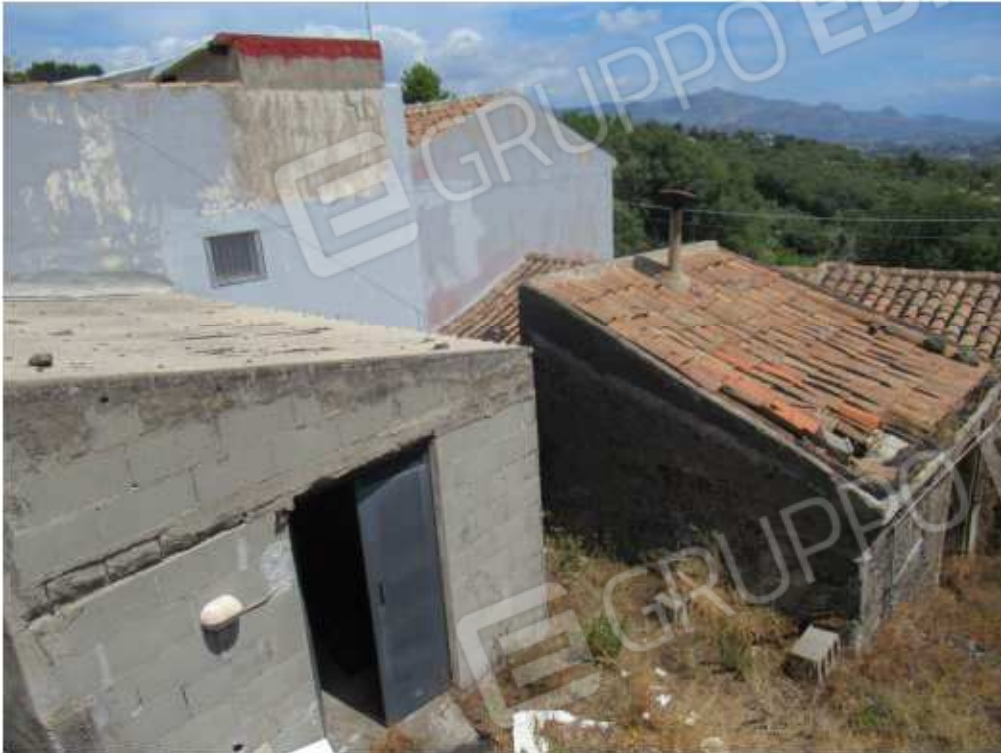
Foto n ° 21 – Zona cortile –
