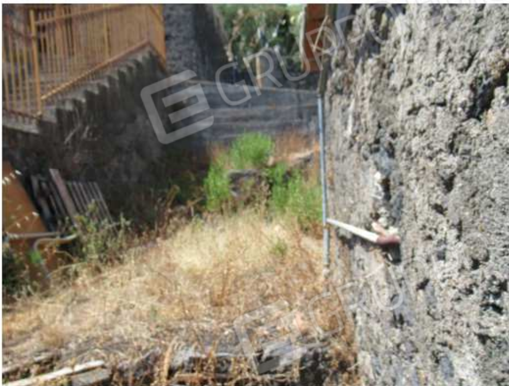
Foto n ° 15 - Zona cortile -
