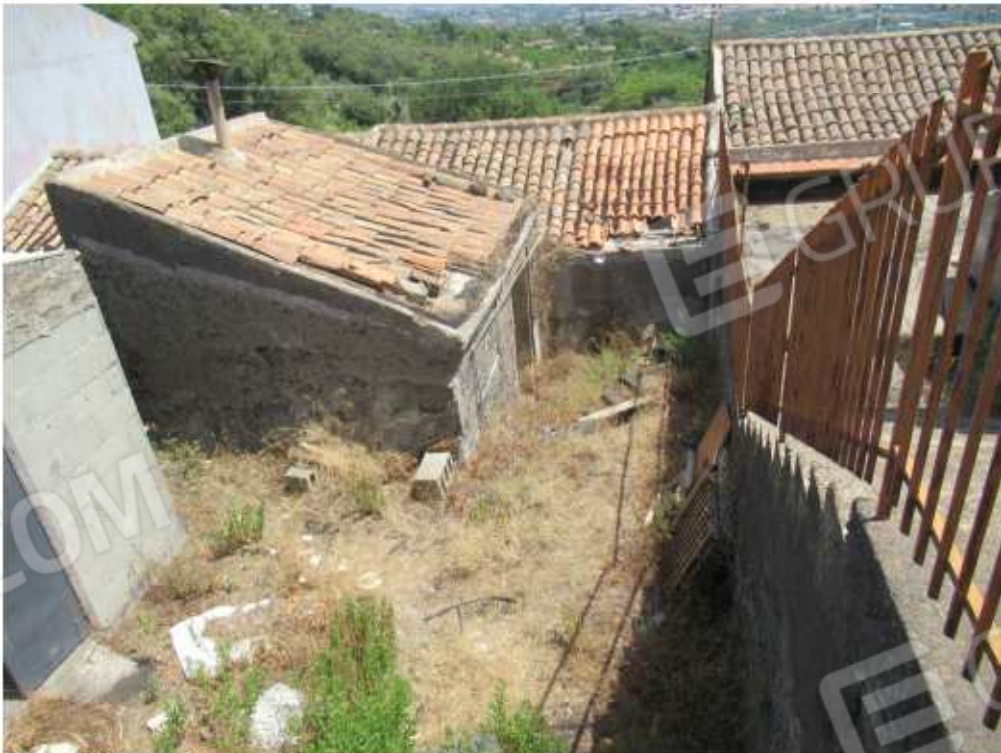
Foto n ° 20 - Zona cortile -
