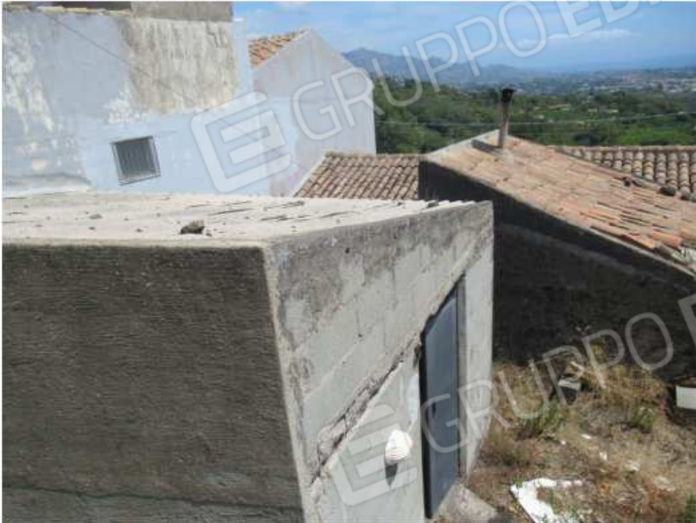
Foto n ° 19 - Zona cortile -
