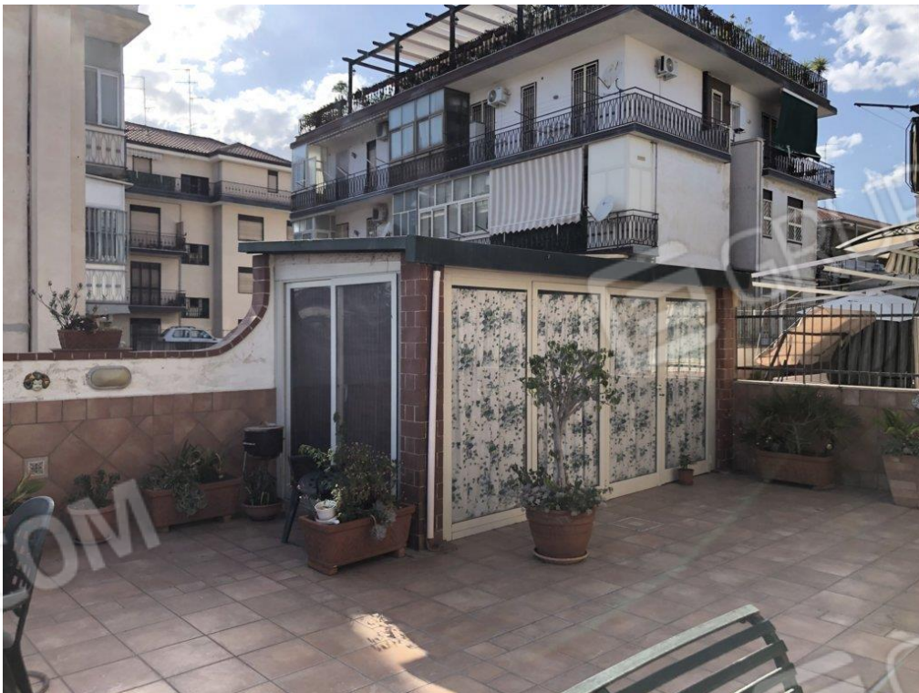
Foto n.16 Vista della costruzione sul terrazzo.
