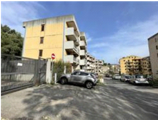
Vista del fabbricato e dell'accesso all'area condominiale retrostante lato monte
