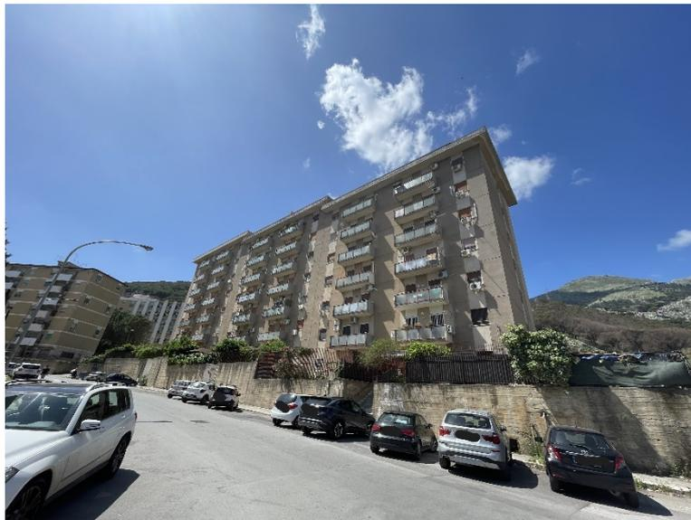
I prospetti, si mostrano in ottimo stato di manutenzione, sono rifiniti con intonaco del tipo Li Vigni e coloriture in parte chiare e parte scure, non presentano nessun segno di usura, alcuni balconi dello
