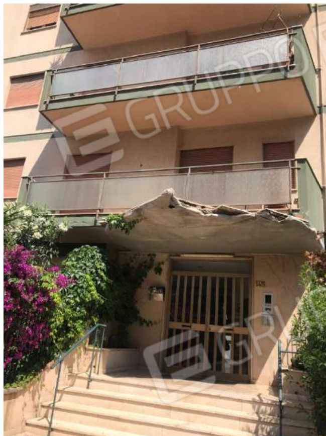
Foto n.3 Accesso all'edificio con particolare pensilina
