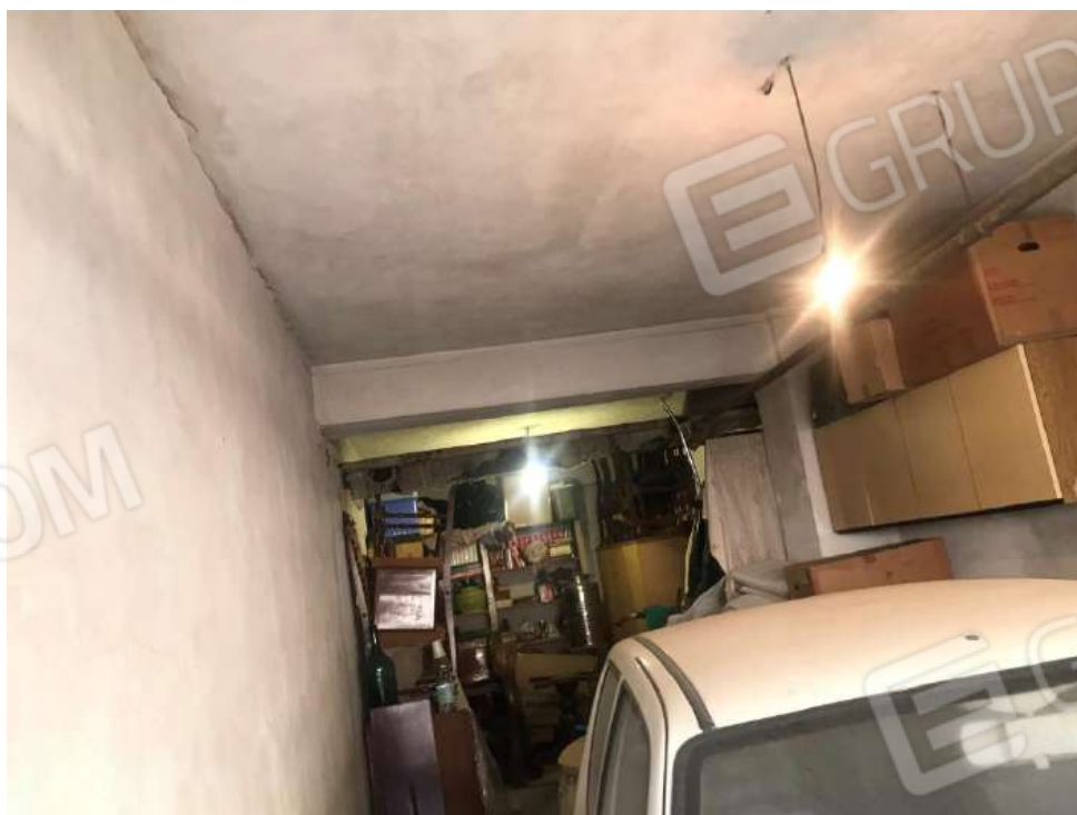
Foto n.20 Locale box: particolare pareti e soffitti
