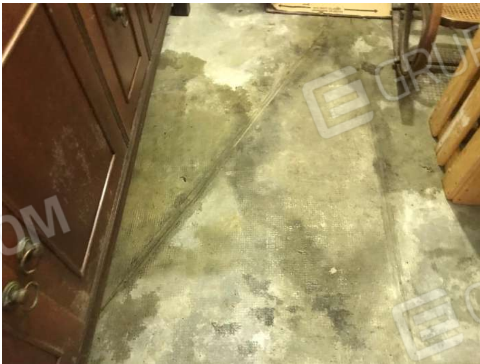
Foto n. 22 Locale box: particolare pavimentazione
