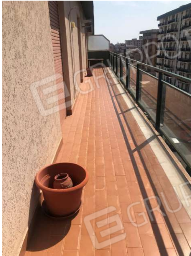
Foto n.13 Appartamento: balcone su via Principe di Paternò
