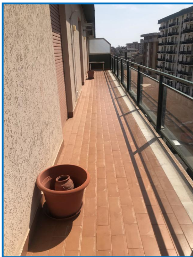
BALCONE SU PROSPETTO PRINCIPALE
