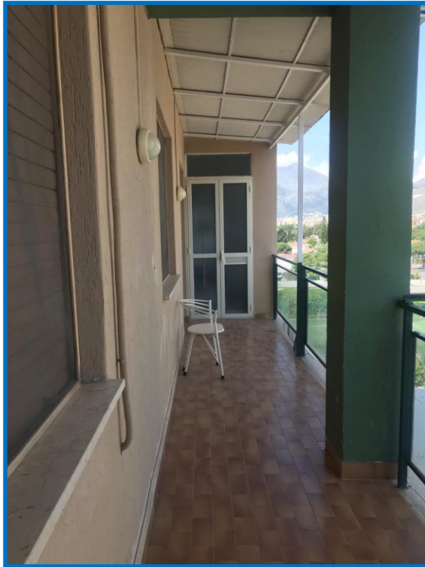
BALCONE SUL RETROSPROSPETTO CON RIPOSTIGLIO
