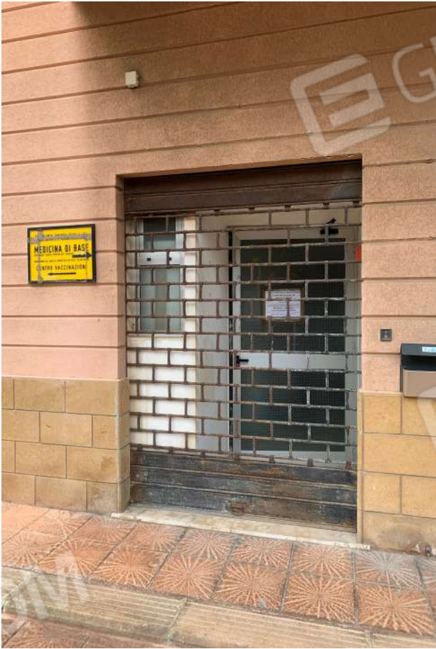
Foto 25 Ingresso sul prospetto esposto a nord-est
