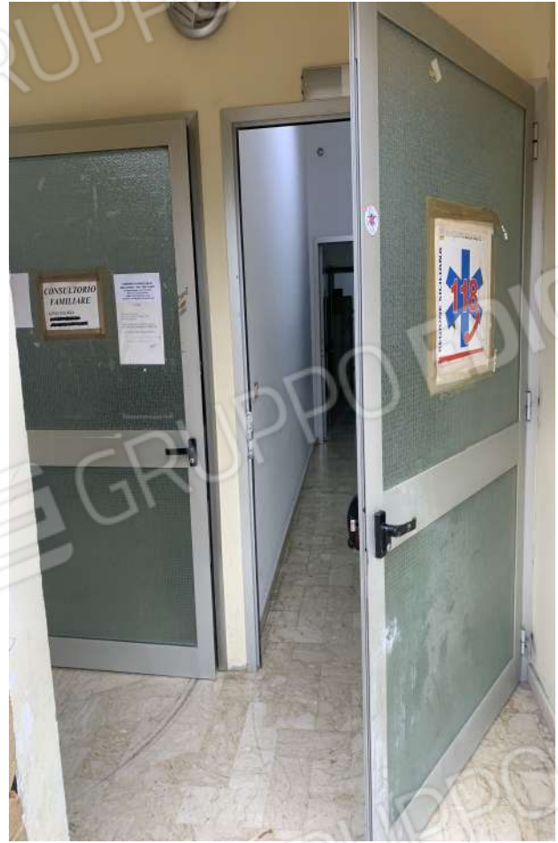
Foto 4 - Il disimpegno con gli ingressi nelle distinte aree dedicate
