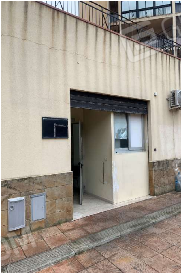
Foto 3 - Ingresso del fabbricato esposto a nord
