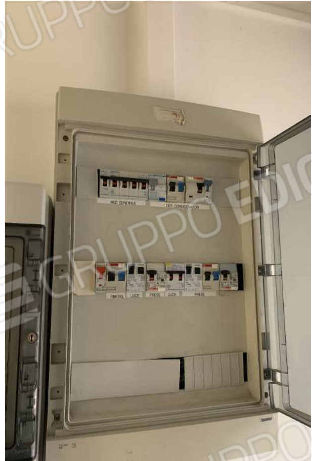
Foto 27 - 28 Il quadro elettrico generale
