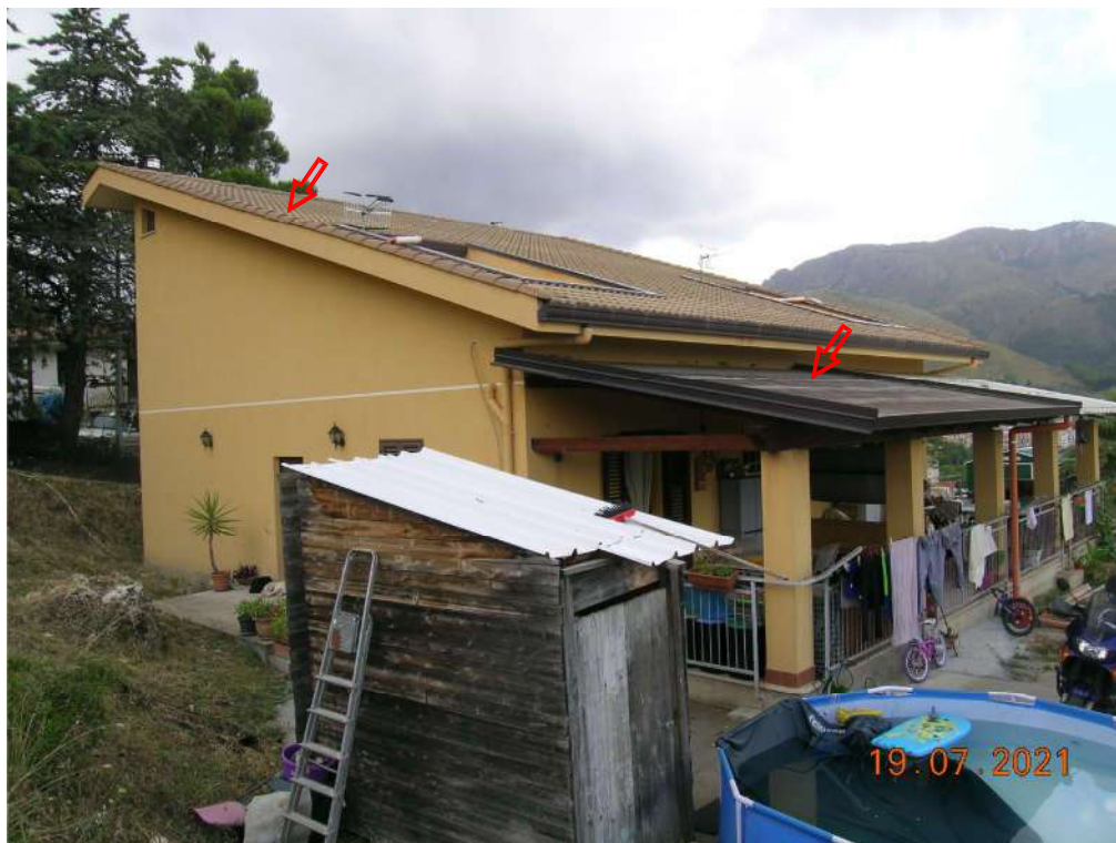
Prospetti est e sud - le frecce indicano la p.lla 2301 sub 1
