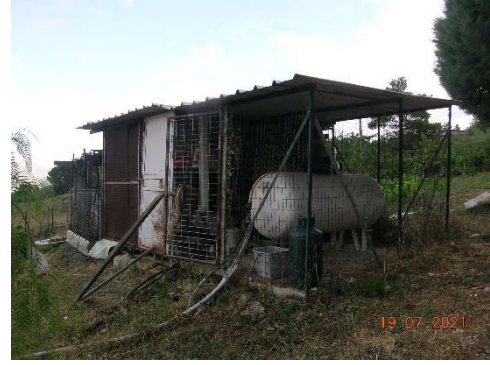
Foto 20 – Serbatoi di accumulo a servizio della villetta bifamiliare (p.lle 2301 sub1 e sub2), ricadenti su p.la 2301 sub 3 (bene comune non censibile)
