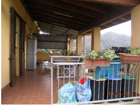
Foto 19 – Portico su fronte est (p.la 2301 sub3)
