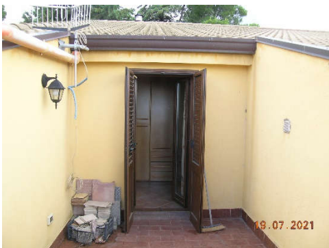
Foto 17- Piano primo: terrazza
