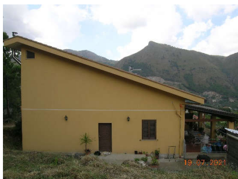
Foto 5 – Prospetto sud p.la 2301 sub 1
